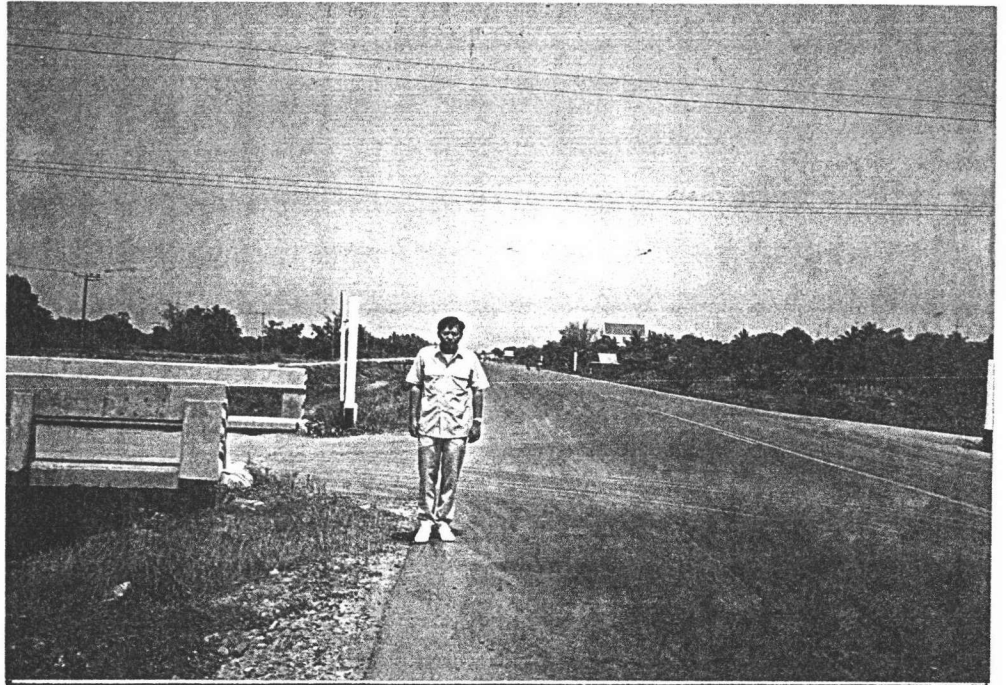
ทางหลวงแผ่นดินหมายเลข 309 ได้มีการปรับปรุง ไหล่ทางลาดยาง ซึ่งเชื่อมโยงชุมชนตำบลตะวันตก ของแม่น้ำเจ้าพระยา
