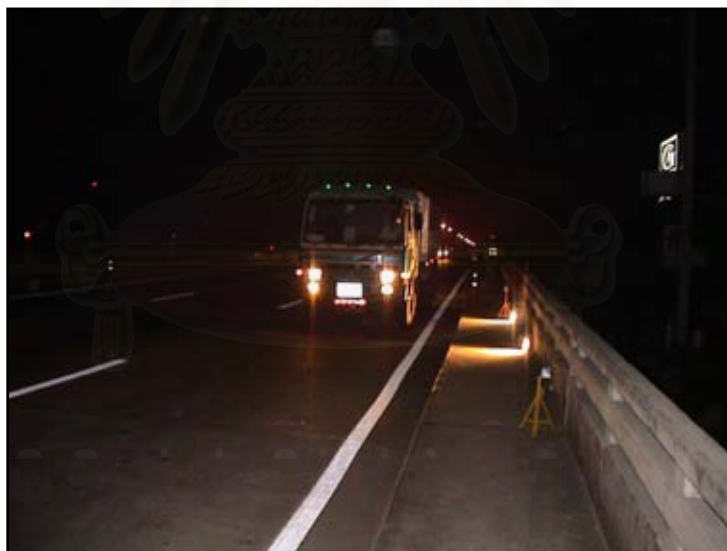
รูปที่ 6.3 การติดตั้งเซ็นเซอร์บอกตำแหน่งรถบรรทุก
