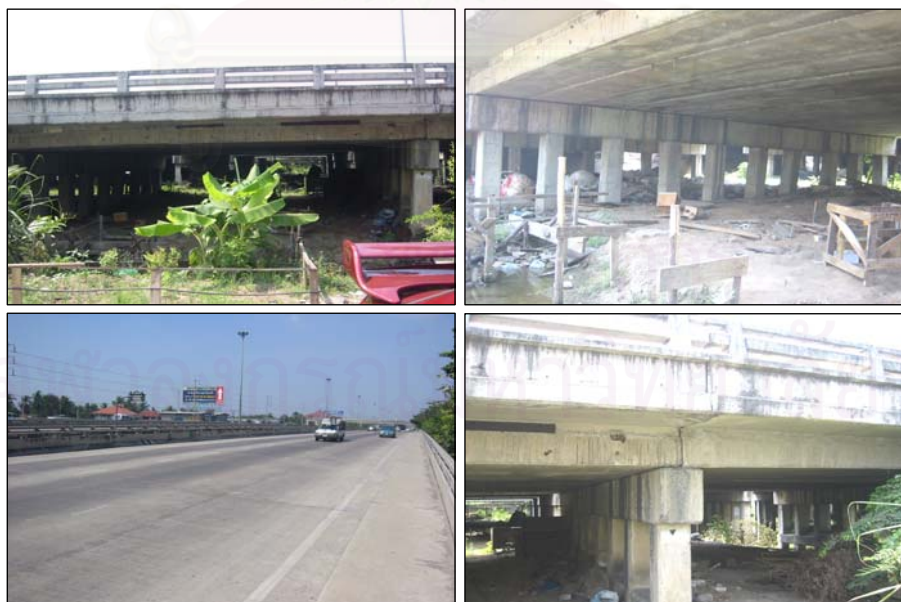
รูปที่ 5.2 สะพานข้ามคลองบางน้อยที่ใช้ในการทดสอบ
