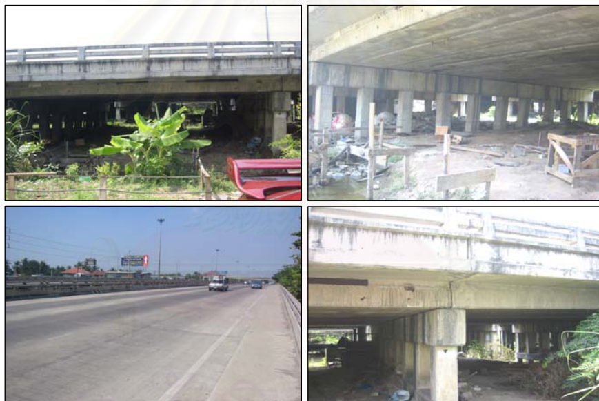
รูปที่ 6.1 สะพานข้ามคลองบางน้อยที่ใช้ในการทดสอบ
