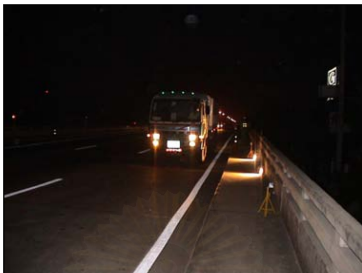
รูปที่ 5.13 การติดตั้งเซ็นเซอร์บอกตำแหน่งรถเข้าและออก
