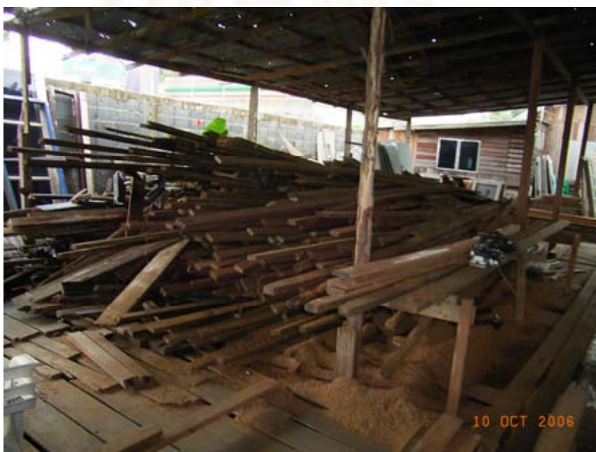
รูปที่ 4.28 การกองเก็บไม้ที่เกิดจากการรื้อถอนสิ่งก่อสร้างเพื่อรอการตกแต่ง
