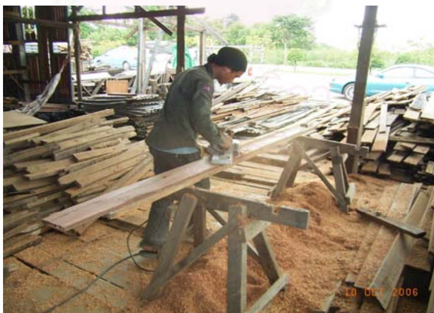
รูปที่ 4.30 การตกแต่งไม้ที่เกิดจากการรื้อถอนสิ่งก่อสร้างโดยการไสไม้
