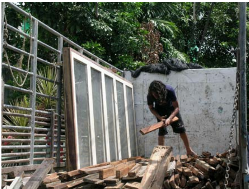
รูปที่ 4.37 การขนย้ายประตูและหน้าต่างไม้ที่เกิดจากการรื้อถอนสิ่งก่อสร้างเพื่อนำไปจัดเก็บ
