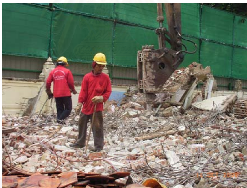
รูปที่ 4.4 การย่อยเศษคอนกรีตที่เกิดจากการรื้อถอนสิ่งก่อสร้างเพื่อแยกเหล็กเสริมคอนกรีต
