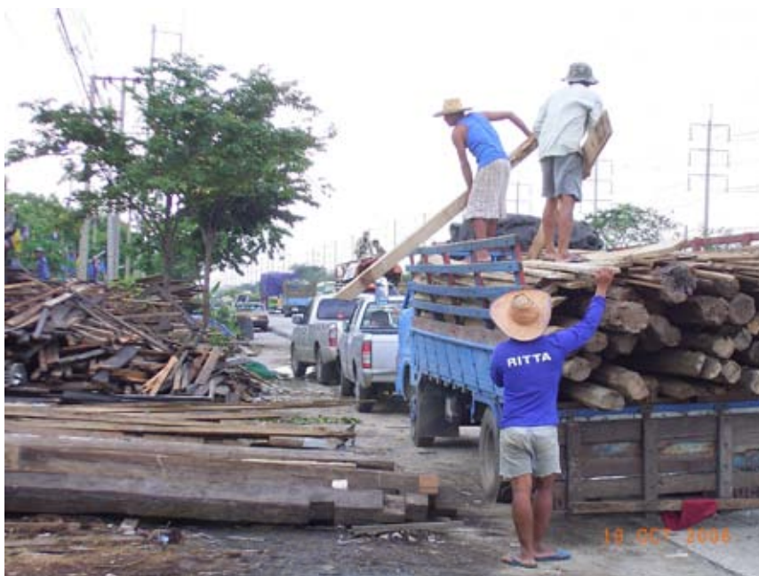
รูปที่ 4.27 การขนย้ายไม้ที่เกิดจากการรื้อถอนสิ่งก่อสร้างเพื่อจัดเก็บในโกดัง
