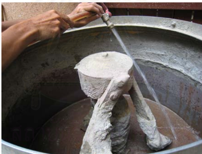
รูปที่ 5.26 การทำความสะอาดเครื่องผสมคอนกรีตก่อนทำการผสมคอนกรีต
