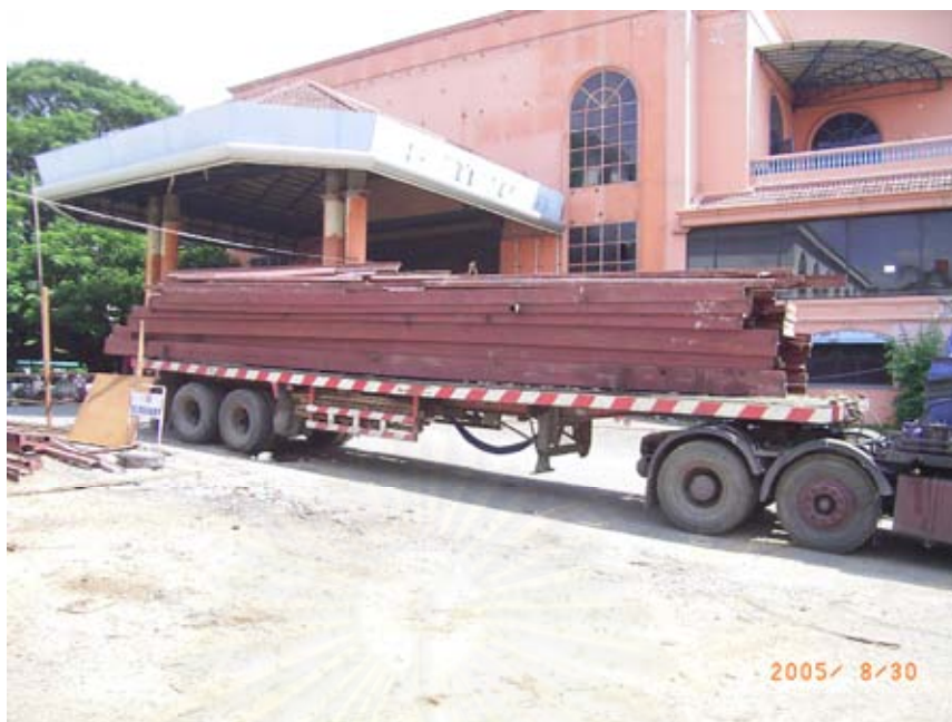
รูปที่ 4.20 การขนย้ายเหล็กรูปพรรณที่เกิดจากการรีดลอนดิ่งก่อสร้าง
