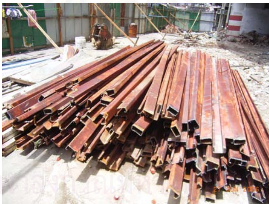
รูปที่ 4.19 การกองเก็บเหล็กรูปพรรณที่เกิดจากการรีไซเคิลสิ่งก่อสร้าง
