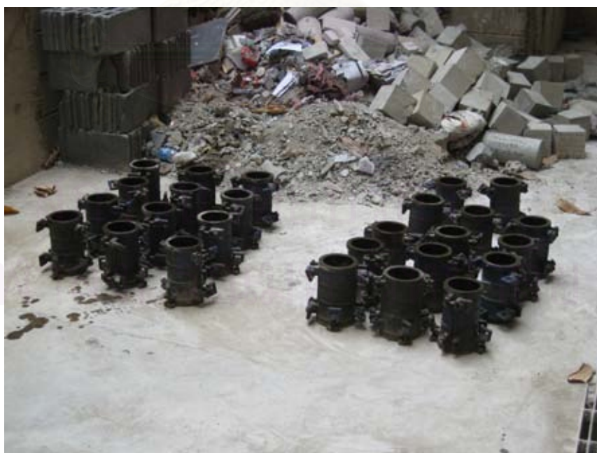
รูปที่ 5.28 การเตรียมแบบหล่อที่ใช้สำหรับหล่อก้อนตัวอย่างคอนกรีต
