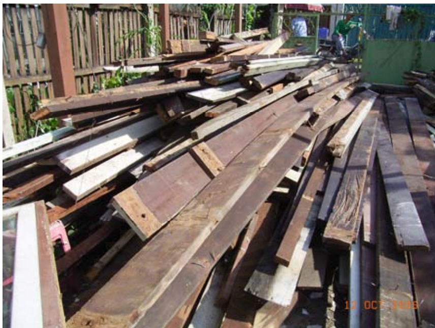
รูปที่ 4.25 การกองไม้ที่เกิดจากการรื้อถอนสิ่งก่อสร้างเพื่อเตรียมการขนย้าย
