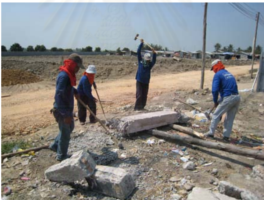
รูปที่ 5.5 การทุบย่อยคานคอนกรีตโดยใช้คนงาน 4 คน
