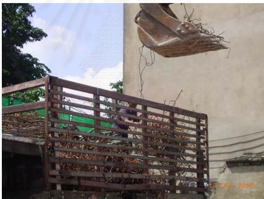
รูปที่ 4.14 การขนย้ายเหล็กเสริมคอนกรีตที่เกิดจากการรื้อถอนสิ่งก่อสร้าง
