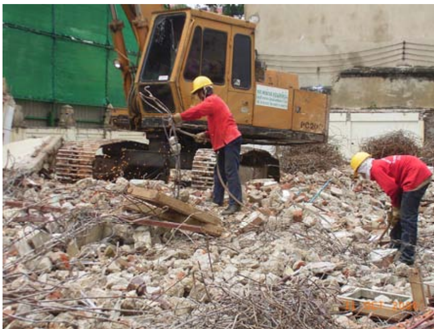
รูปที่ 4.11 การแยกเหล็กเสริมคอนกรีตออกจากเศษคอนกรีตที่เกิดจากการรื้อถอนสิ่งก่อสร้าง
