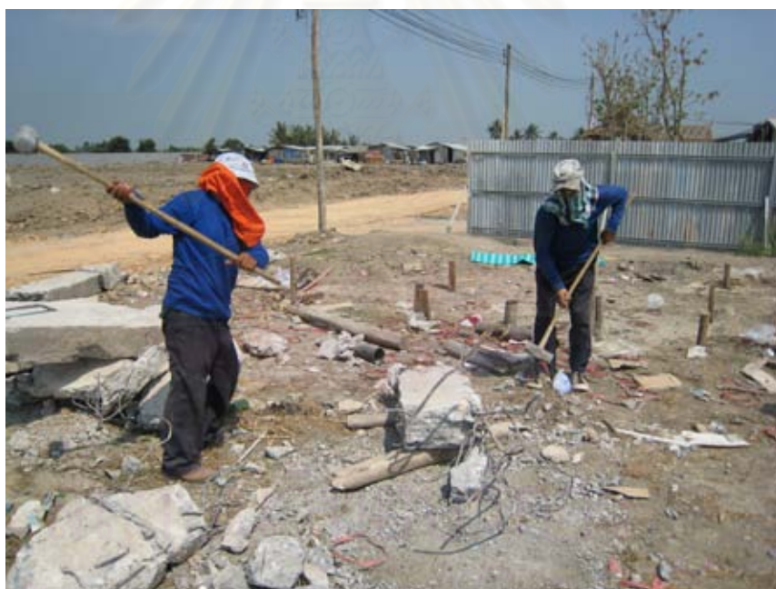
รูปที่ 5.3 การทุบย่อยคานคอนกรีตโดยใช้คนงาน 2 คน
