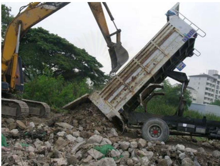
รูปที่ 4.8 การนำเศษคอนกรีตที่เกิดจากการรื้อถอนสิ่งก่อสร้างมาทำถนนชั่วคราว
