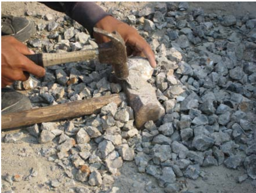
รูปที่ 5.10 การทุบย่อยเศษคอนกรีตโดยใช้ค้อนขนาดเล็ก
