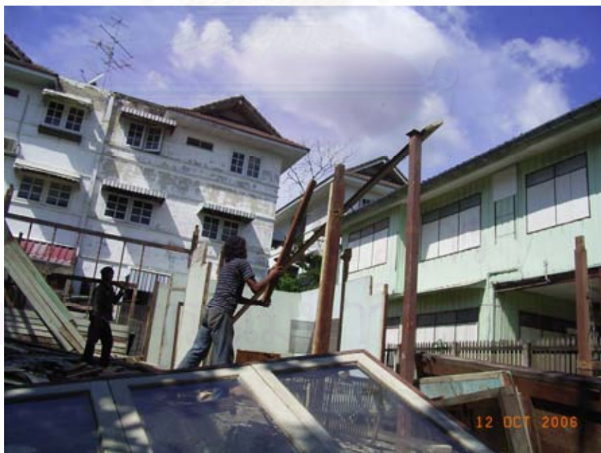
รูปที่ 4.24 การรื้อถอนโครงสร้างของสิ่งก่อสร้างส่วนที่เป็นไม้
