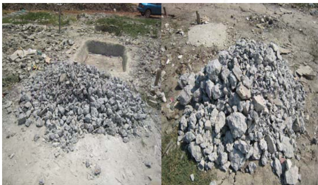
รูปที่ 5.9 เศษคอนกรีตที่ได้จากการทุบย่อยในขั้นตอนที่ 1
