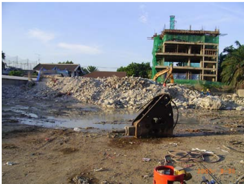
รูปที่ 4.5 การกองเก็บเศษคอนกรีตที่เกิดจากการรื้อถอนสิ่งก่อสร้างเพื่อรอการขนย้าย
