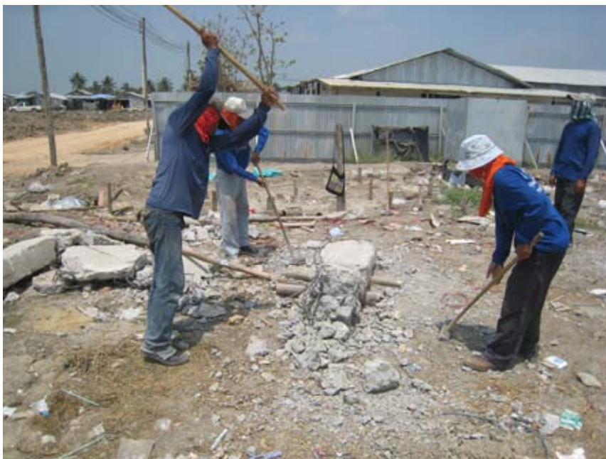
รูปที่ 5.4 การทุบย่อยคานคอนกรีตโดยใช้คนงาน 3 คน
