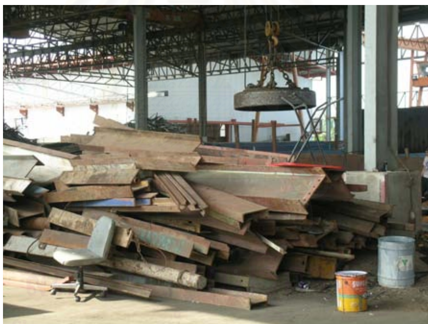
รูปที่ 4.21 การกองเก็บเหล็กรูปพรรณที่เกิดจากการรีดลอนดิ่งก่อสร้างเพื่อรอการนำไปใช้ใหม่
