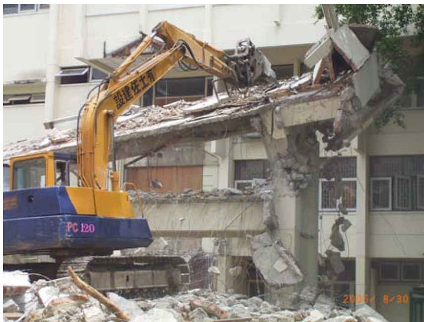
รูปที่ 4.3 การรื้อถอนโครงสร้างของสิ่งก่อสร้างโดยใช้เครื่องจักร
