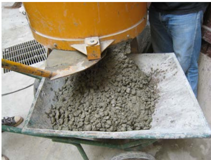
รูปที่ 5.27 คอนกรีตที่ได้จากการผสม
