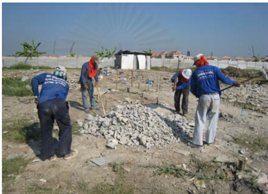
รูปที่ 5.8 การทุบย่อยเศษคอนกรีตทำโดยใช้ก้อนขนาดใหญ่
