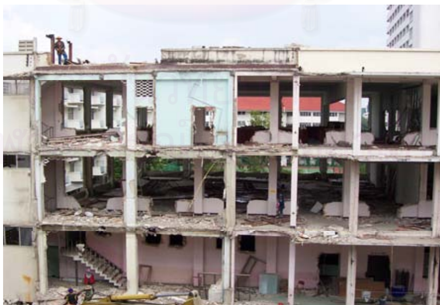
รูปที่ 4.2 โครงสร้างคอนกรีตเสริมเหล็ก หรือผนังอิฐบล็อกฉาบคอนกรีตซึ่งถูกรื้อถอน
