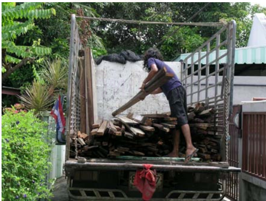
รูปที่ 4.26 การขนย้ายไม้ที่เกิดจากการรื้อถอนสิ่งก่อสร้างขึ้นรถเพื่อรอการจำหน่าย
