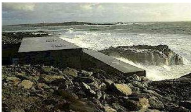
รูปที่ 3-8 อุปกรณ์แปลงพลังงานคลื่น ให้เป็นพลังงานไฟฟ้า Limpet [32]
