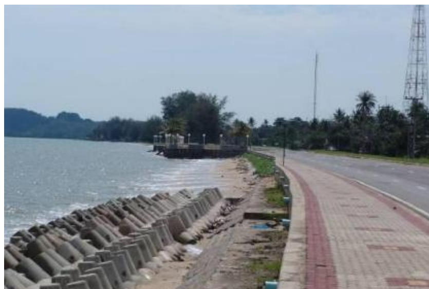
รูปที่ 3-5 การป้องกันการกัดเซาะด้วยกำแพงกันคลื่น [31]
