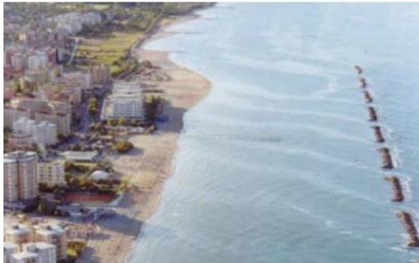
รูปที่ 3-4 การป้องกันการกัดเซาะด้วยเขื่อนกันคลื่น [31]
