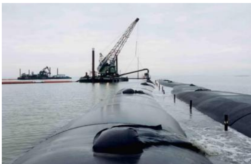
รูปที่ 3-6 การป้องกันการกัดเซาะด้วยใ้กรอกทราย [31]
