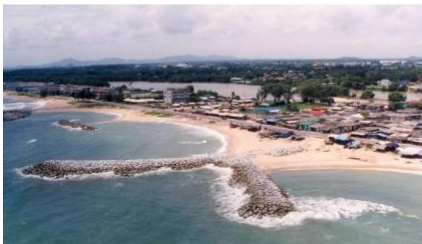
รูปที่ 3-3 การป้องกันการกัดเซาะด้วยคันดักทราย [31]
