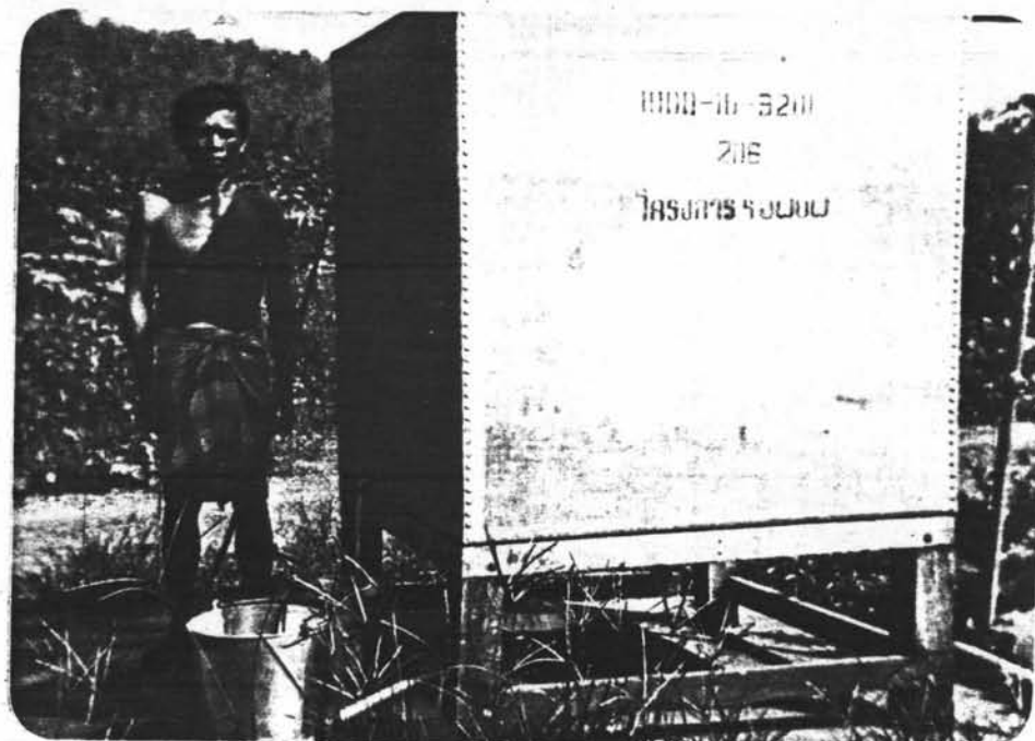
รูปที่ 3.4 แสดงลักษณะรูปร่างของถังจ่ายน้ำขนาด 400 กล.
