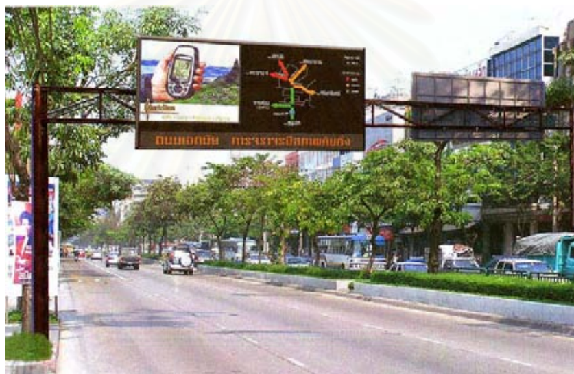
รูปที่ 2.26 การติดตั้งป้ายจราจรอัจฉริยะของสำนักงานจราจรและขนส่ง (สจส.) กรุงเทพมหานคร
