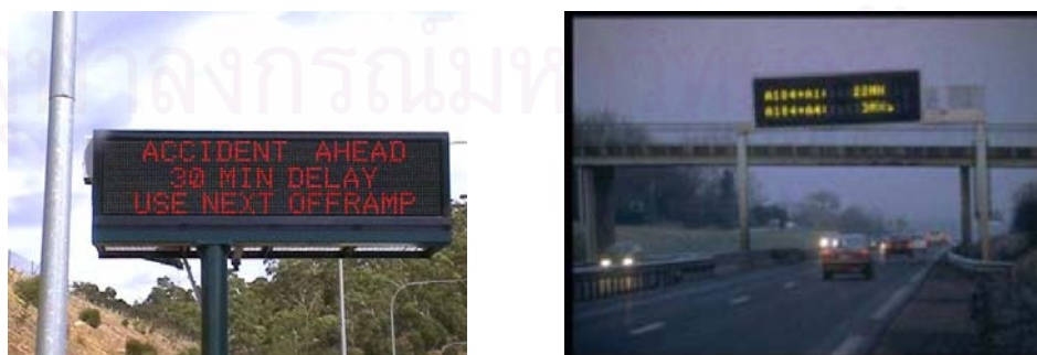
รูปที่ 2.10 ป้ายจราจรสลัข้อความแสดงข้อมูลทั่วไป และข้อมูลเชื่อมโยงเส้นทาง
