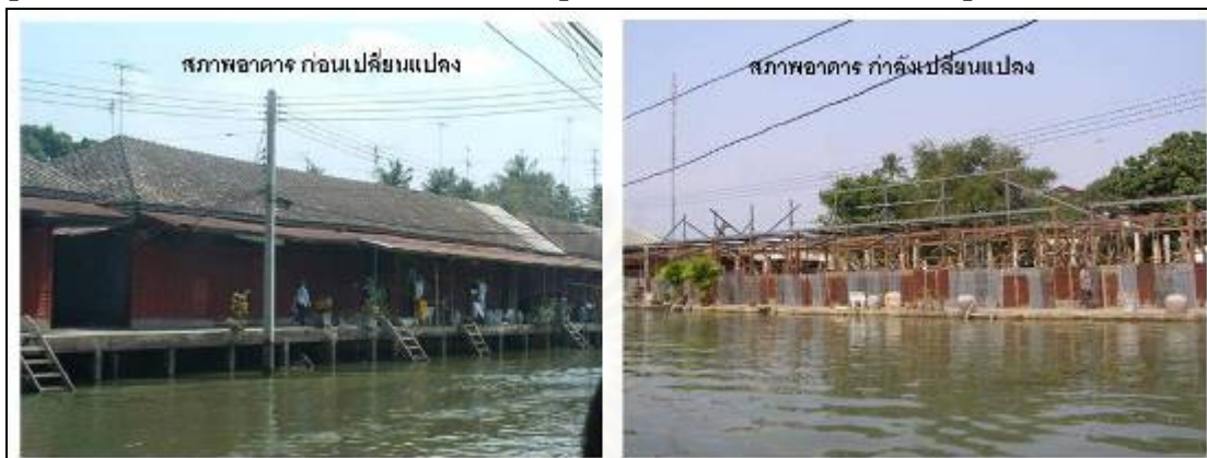
รูปที่ 5.20 สภาพอาคาร ก่อนและหลังที่อยู่ระหว่างการเปลี่ยนแปลงตามรูปแบบ C
