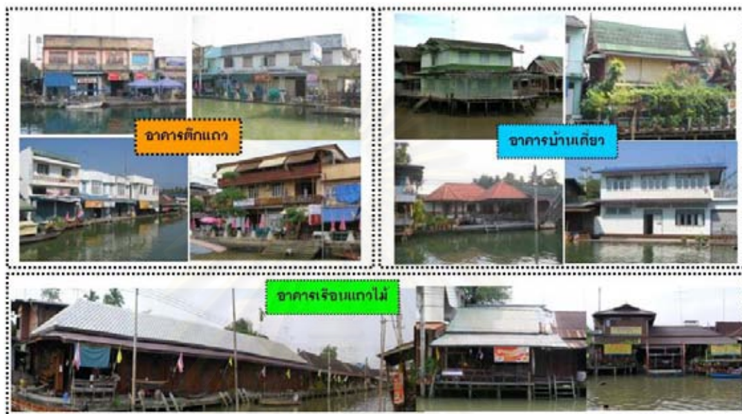
รูปที่ 4.12 รูปแบบอาคารอยู่อาศัยหลังการฟื้นฟู
