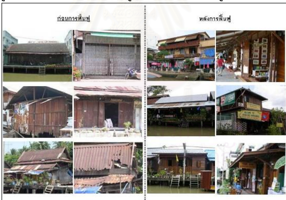
รูปที่ 5.32 แสดงตัวอย่างสภาพอาคารอยู่อาศัยก่อนและหลังการฟื้นฟู
