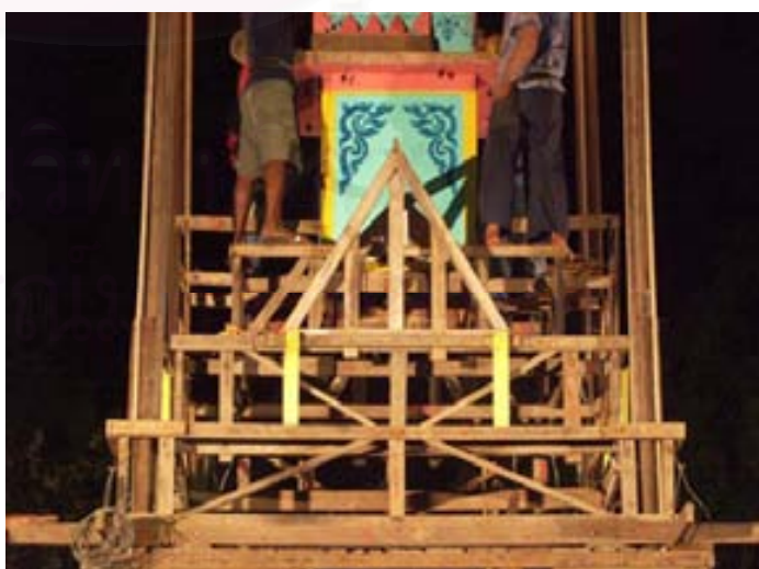
ภาพที่ 4.2.2.3.16 จากส่วนช่อ โครงสร้างของส่วนยอดมรุจะถูกประกอบขึ้นไปเป็นชั้นๆ ลดหลั่นกันขึ้นไปจนถึงส่วนยอด
