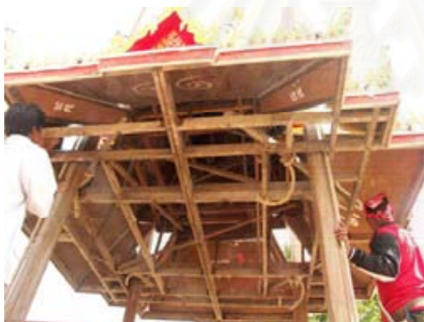
ภาพที่ 4.2.3.2.5 โครงสร้างส่วนยอด เมรุชั่วคราววัดพระทอง
