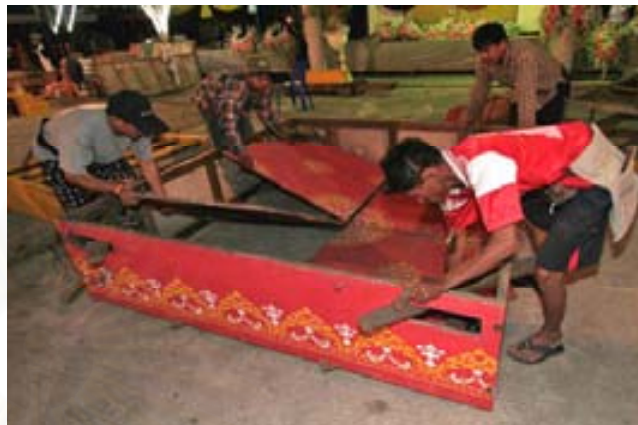
ภาพที่ 4.2.1.3.5 ช่างเมรุวัดเกาะกำลังช่วยกันประกอบส่วนคอสอง และเพดานเมรุประธาน
