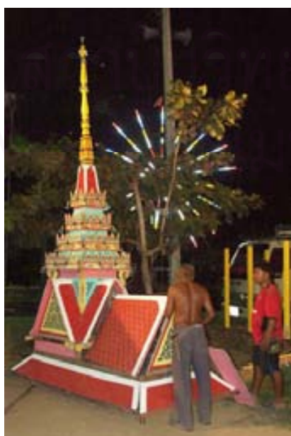
ภาพที่ 4.2.2.3.13 ช่างกำลังทำการประกอบส่วนหลังคาและส่วนยอดของเมรุทิศที่พื้น
