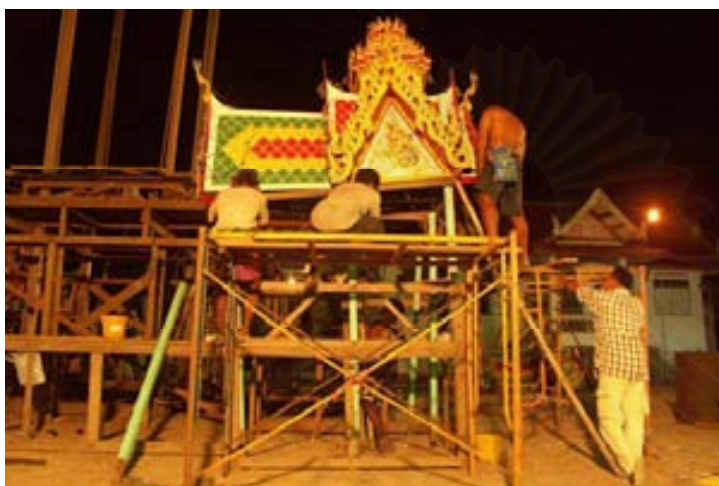
ภาพที่ 4.2.3.3.10 ช่างกำลังทำการติดตั้งเสารับส่วนยอดของเมรุทิศ
