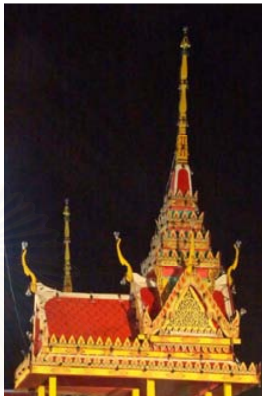
ภาพที่ 4.2.2.1.6 องค์ประกอบส่วนหลังคาและเครื่องยอดของเมรุทิศ วัดประดิษฐานาราม
