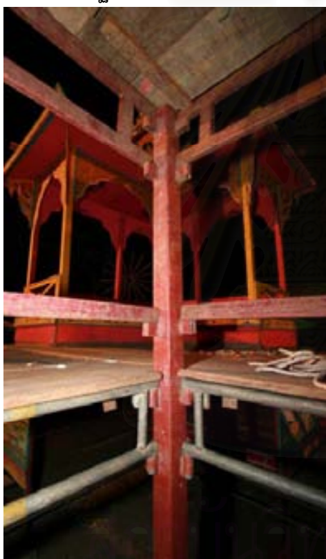
ภาพที่ 4.2.4.2.1 เสาเหล็กรับคานและแผงฐาน
