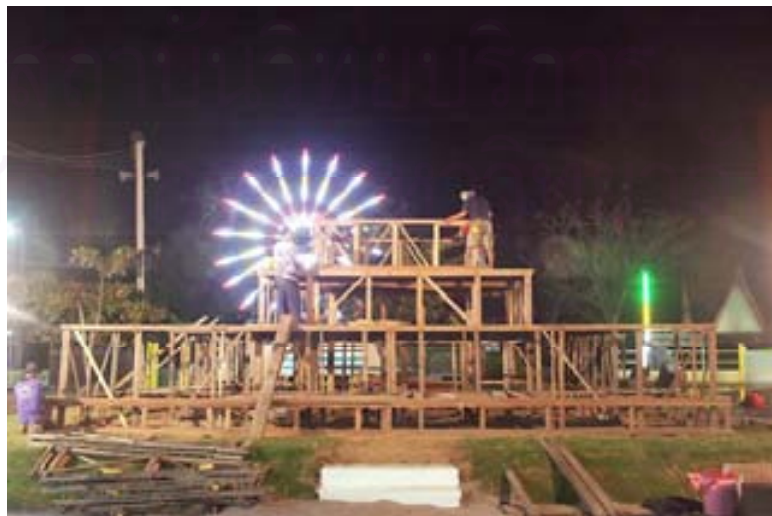
ภาพที่ 4.2.2.3.10 ช่างกำลังทำการประกอบแฉงฐานชั้นที่ 4 ซึ่งเป็นฐานชั้นสุดท้าย
