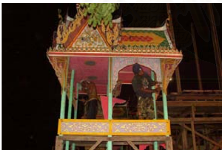
ภาพที่ 4.2.3.3.11 ช่างกำลังทำการประกอบชิ้นส่วนในเรือนธาตุของเมรุทิศ อันได้แก่ ซุ้มคูหา คันทวย และพนักระเบียง
