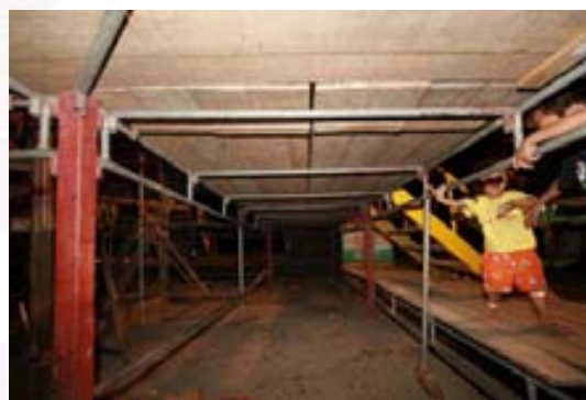
ภาพที่ 4.2.4.2.3 ตงเหล็กรูปพรรณรับพื้นไม้
