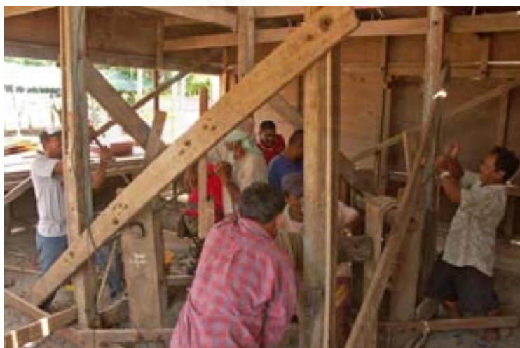
ภาพที่ 4.2.3.3.14 ช่างเมรุวัดพระทองกำลังช่วยกันออกแรงหมุนเพลากว้านเชือกยกส่วนยอดของเมรุประธานขึ้น
