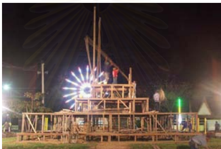
ภาพที่ 4.2.2.3.14 ช่างกำลังยกเสาแก้วช่วงบนขึ้นติดตั้ง
