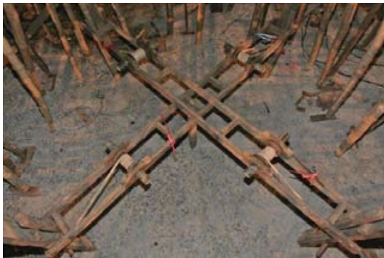
ภาพที่ 4.2.1.2.4 รอกและเพลา โครงสร้างพิเศษที่ยึดอยู่กับเสากร่วง ช่วยให้เสากร่วงแข็งแรง
