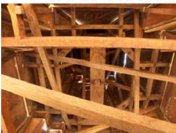
ภาพที่ 4.2.3.2.6 โครงสร้างส่วนยอดที่วางเรียงขึ้นไปเป็นชั้นๆ
