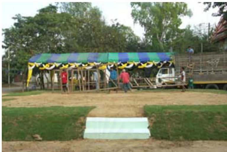
ภาพที่ 4.2.2.3.3 พื้นที่ตั้งเมรุซึ่งทางเจ้าภาพเป็นผู้จัดเตรียมไว้ โดยถมเป็นเนินดินฝังรูปสี่เหลี่ยมจัตุรัส พร้อมทั้งทำบันไดทางขึ้นไว้ทั้งสองด้าน
