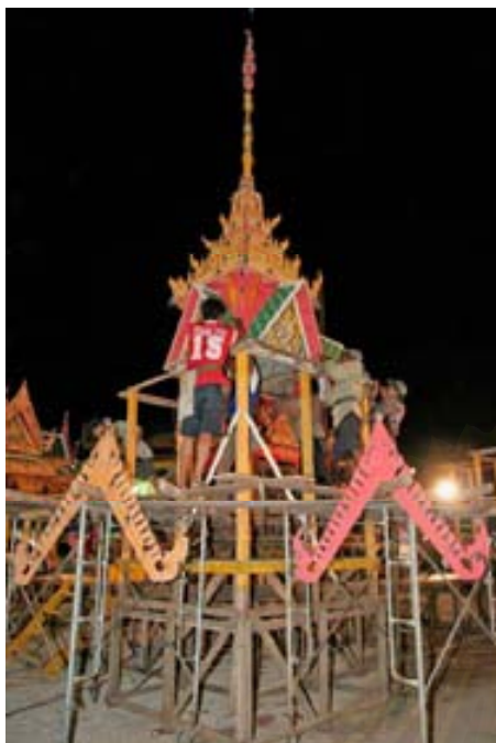
ภาพที่ 4.2.1.3.7 ช่างเมรุวัดเกาะกำลังประกอบ ส่วนยอดเมรุทิศ
