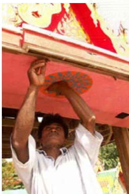
ภาพที่ 4.2.3.3.15 ช่างกำลังทำการติดชิ้นส่วนเพดานไชรา โดยช่างติดแผ่นเหล็กห้อยไว้กับส่วนโครงคร่าวของชั้นไชราเป็นระยะๆ เสียบแผ่นเพดานซึ่งทำการเจาะรูไว้ให้พอดีกับขนาดของแผ่นเหล็ก ใช้หมุดเหล็ก หรือตะปู เสียบขัดไว้ไม่ให้แผ่นเพดานตกลงมา
