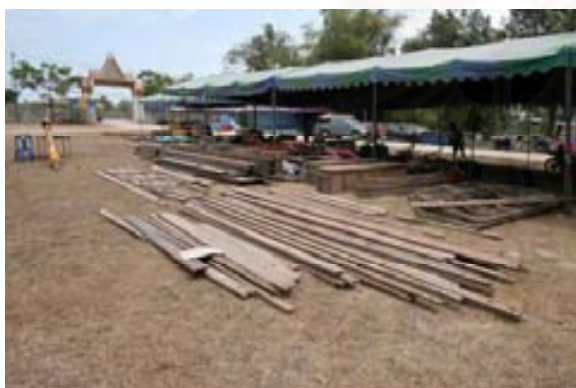
ภาพที่ 4.2.3.3.1 การจัดเรียงแยกชิ้นส่วนประกอบของเมรุชั่วคราว หลังจากทำการขนถ่ายลงจากรถบรรทุก
