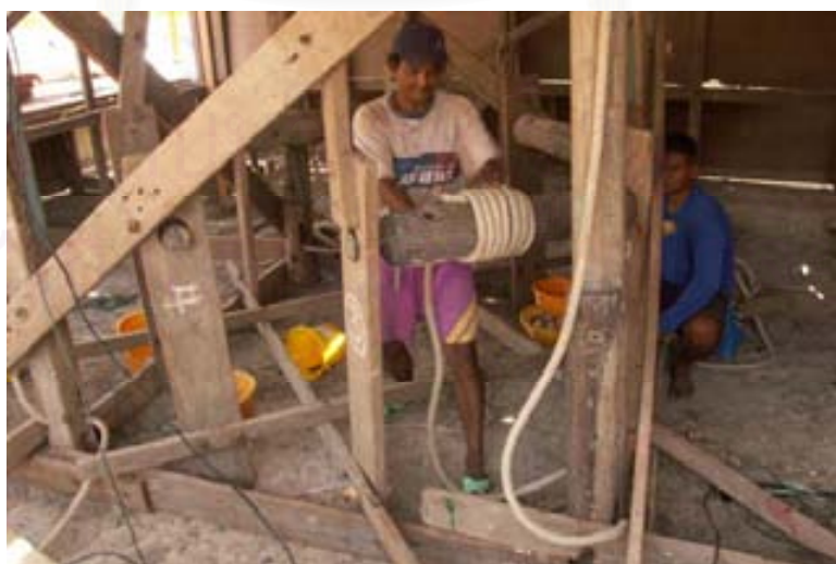
ภาพที่ 4.2.3.3.13 ช่างกำลังทำการติดตั้งรอกและเพลา สำหรับใช้ยกส่วนยอดของเมรุประธาน
