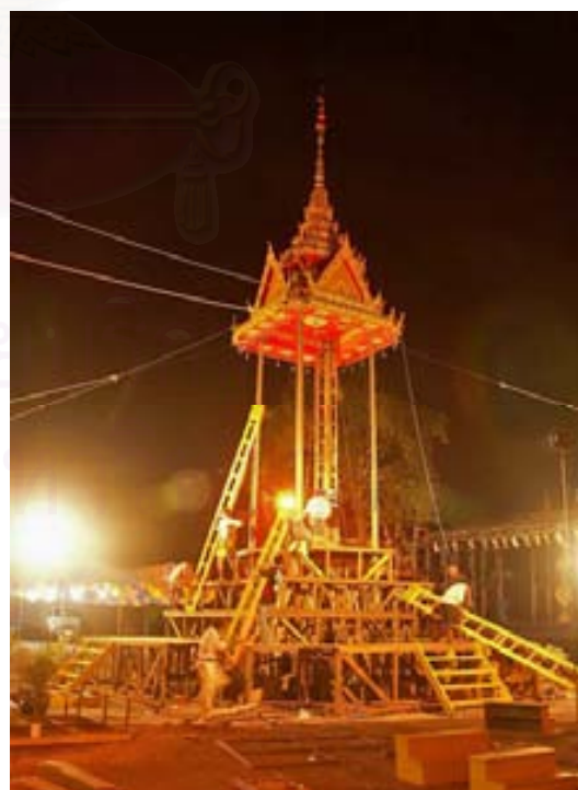
ภาพที่ 4.2.1.2.3 แผงปิดเสา โครงสร้างส่วนเรือนธาตุ
