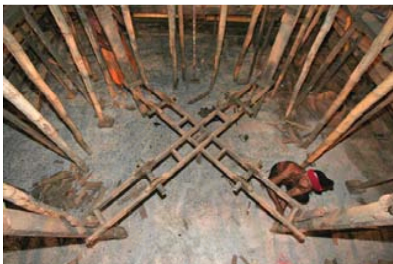
ภาพที่ 4.2.1.3.12 ช่างเมรุวัดเกาะกำลังติดตั้งรอกและเสากว้าง
