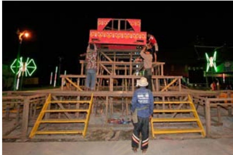
ภาพที่ 4.2.1.3.9 ช่างเมรุวัดเกาะกำลังประกอบส่วนหลังคาและเครื่องยอดเมรุประธาน
