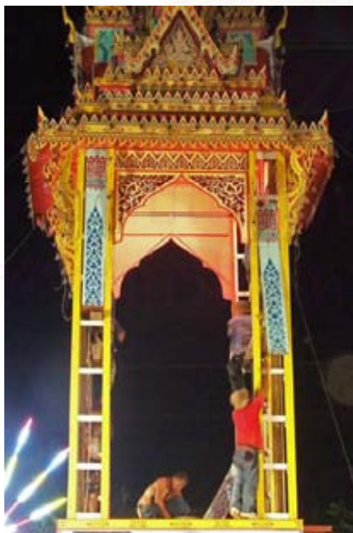
ภาพที่ 4.2.2.3.22 ช่างกำลังทำการติดตั้งส่วนประกอบ ส่วนเรือนธาตุของเมรุประธาณ
