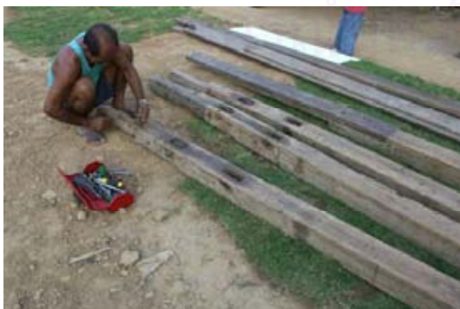
ภาพที่ 4.1.3.2.1 ช่างกำลังเตรียมเสากว้างก่อนทำการติดตั้ง (เมรุวัดประดิษฐนาราม)
