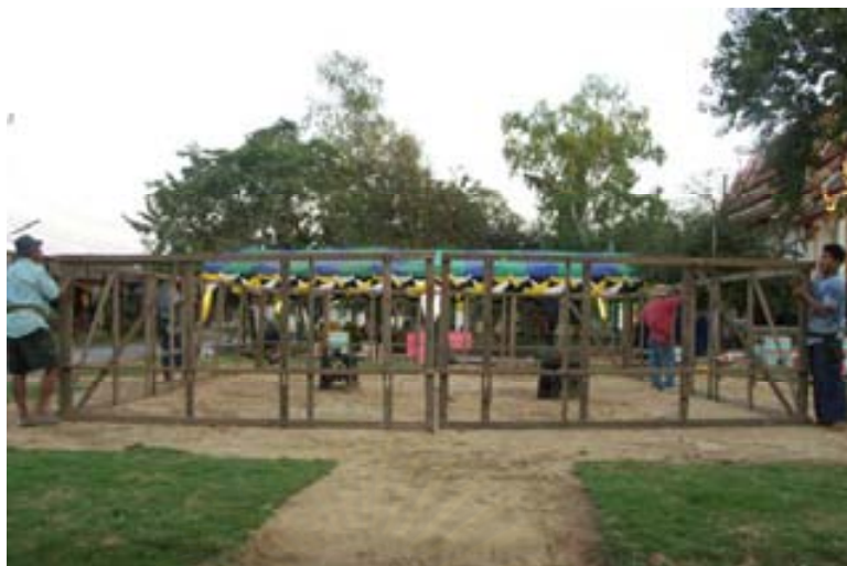
ภาพที่ 4.2.2.3.5 ช่างกำลังประกอบโครงสร้างส่วนฐาน
