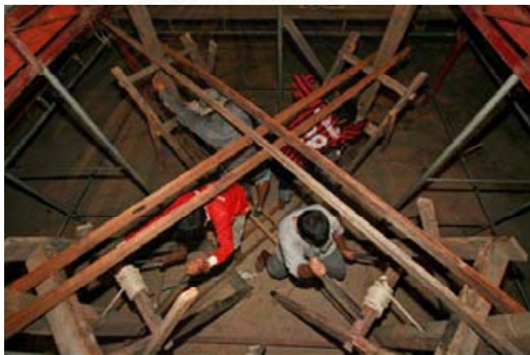
ภาพที่ 4.2.4.3.5 ช่างวัดยางกำลังช่วยกันหมุนเพลากว้างเชือกยกยอดเมรุประธาน
