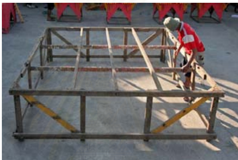
ภาพที่ 4.2.1.3.2 ช่างเมจวัดเกาะกำลังประกอบโครงสร้างส่วนฐานชั้นที่ 4
