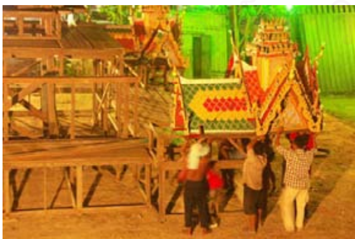
ภาพที่ 4.2.3.3.9 ช่างกำลังทำช่วยกันยก ส่วนยอดเมรุทิศที่ประกอบเสร็จแล้วขึ้น ไปไว้บนฐานชั้นที่ 2 ของเมรุทิศ เพื่อทำ การประกอบส่วนเรือนธาตุต่อไป
