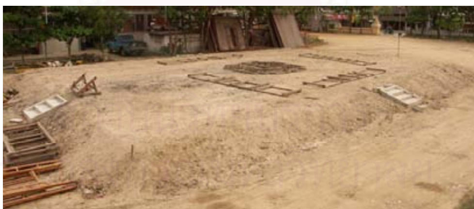
ภาพที่ 4.2.3.3.3 การกำหนดจุดและตำแหน่งในการเริ่มต้นประกอบโครงสร้างส่วนฐาน
