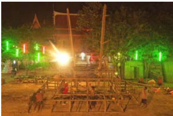
ภาพที่ 4.2.3.3.4 ช่างกำลังติดตั้งเสากว้าน
