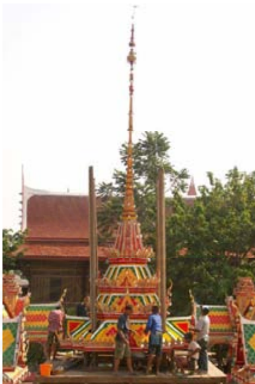
ภาพที่ 4.2.3.3.12 ช่างกำลังทำการประกอบส่วนยอดของเมรุประธาน
