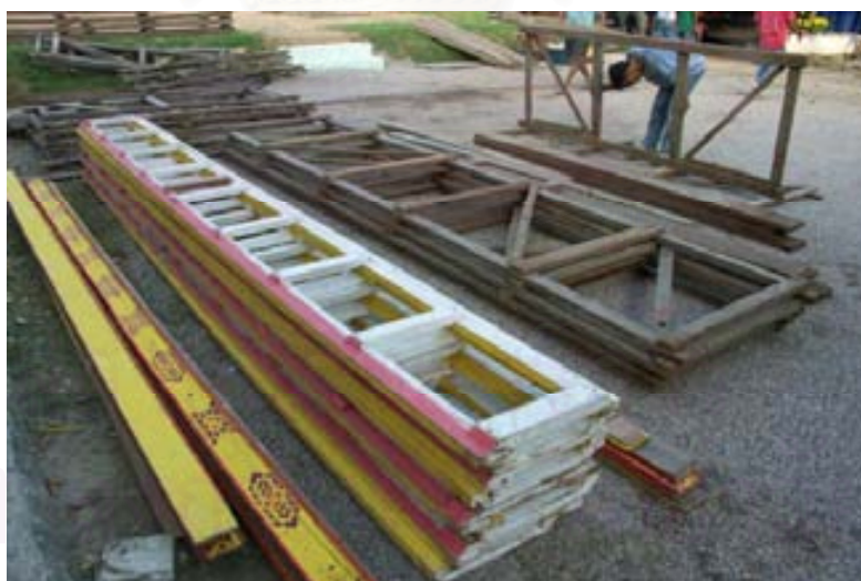
ภาพที่ 4.2.2.3.2 การจัดเรียงชิ้นส่วนประกอบของเมรุ ส่วนประกอบประเภทเดียวกันจะถูกนำมาจัดวางไว้ด้วยกันอย่างเป็นระเบียบ
