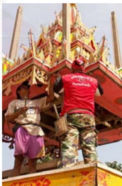
ภาพที่ 4.2.3.3.16 ช่างกำลังทำการติดชิ้นส่วนเฟืองระย้าและพู่ห้อย โดยช่างจะตอกตะปูยึดชิ้นส่วนเข้ากับไม้เชิงกลอน
