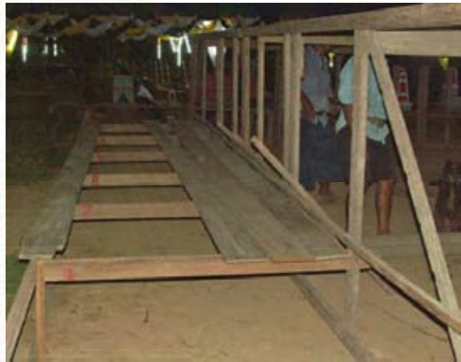
ภาพที่ 4.2.2.3.9 ช่างทำการปูพื้นไม้ของฐานชั้นที่ 1 โดยมีตงเป็นโครงสร้างในการรองรับแผ่นไม้พื้น
