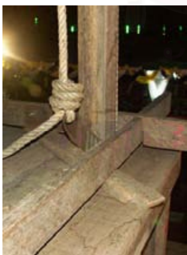
ภาพที่ 4.2.2.3.15 ปลายเชือกแก้วด้านหนึ่ง จะถูกผูกติดกับเพลาเหล็กที่ยึดเข้ากับส่วนมุมของช่อซึ่งล้อมเสาแก้วไว้
