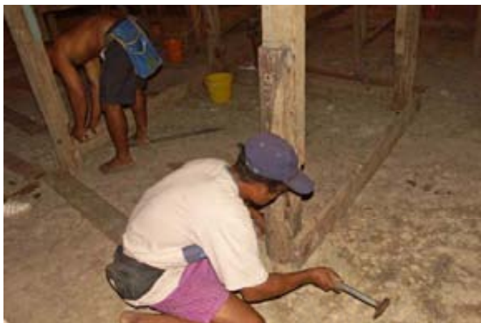
ภาพที่ 4.2.3.3.7 คานยึดโคนเสาแก้วาน เมื่อช่างทำการตั้งไม้โครงสร้างไขว่ ขึ้นไปแล้ว ช่างจะนำไม้ขนาด 1 1/2" X 6" มาตีรัดไว้โดยรอบเสาแก้วานทั้ง 4 ต้น เพื่อไม่ให้ขยับออกจากตำแหน่งที่ กำหนดไว้ คานยึดโคนเสาแก้วานนี้จะยึด ติดกับเสาแก้วานโดยใช้เดือยเหล็กร้อยเข้า ไปในรูที่เจาะเตรียมไว้แล้วขันให้แน่น ด้วยน็อต
