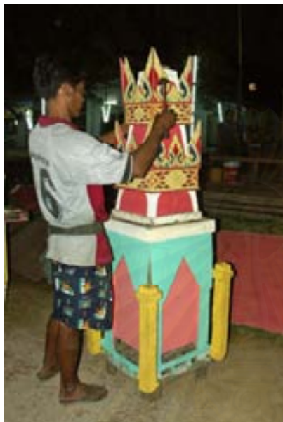
ภาพที่ 4.2.2.3.11 ช่างกำลังทำการประกอบองค์ระฆังเครื่องยอดของเมรุประธาน
