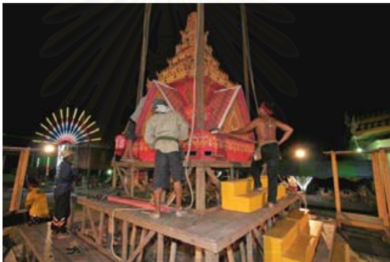
ภาพที่ 4.2.1.3.10 ช่างเมรุวัดเกาะกำลังประกอบส่วนหลังคาและเครื่องยอดเมรุประธาน
