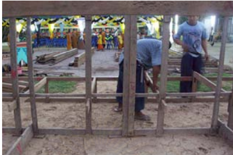
ภาพที่ 4.2.2.3.7 ช่างกำลังติดตั้งเพื่อรองรับพื้นไม้ของฐานชั้นที่ 1
