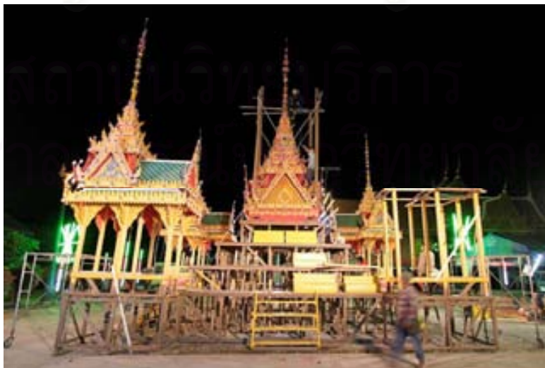
ภาพที่ 4.2.1.3.11 ช่างเมรุวัดเกาะกำลังประกอบส่วนหลังคาและเครื่องยอดเมรุประธาน และเมรุทิศ
