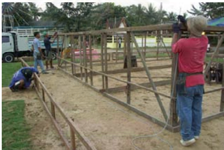
ภาพที่ 4.2.2.3.6 ช่างกำลังตรวจสอบระดับโดยใช้สายยางบรรจุน้ำในการวัดระดับ
