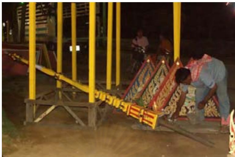
ภาพที่ 4.2.2.3.17 หัวหน้าช่างกำลังประกอบพิธีกรรมเพื่อความเป็นสิริมงคล ก่อนที่จะนำขึ้นส่วน ส่วนหน้าบัน และส่วนยอดขึ้นประกอบ
