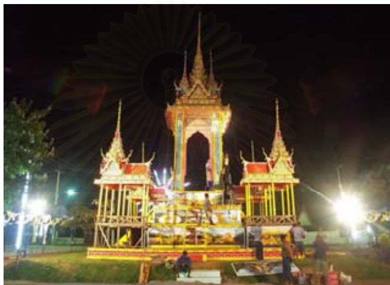
ภาพที่ 4.2.2.3.23 การติดตั้งเมรุทิศ แผงส่องถนุ และบันไดทางขึ้นสู่เมรุ
