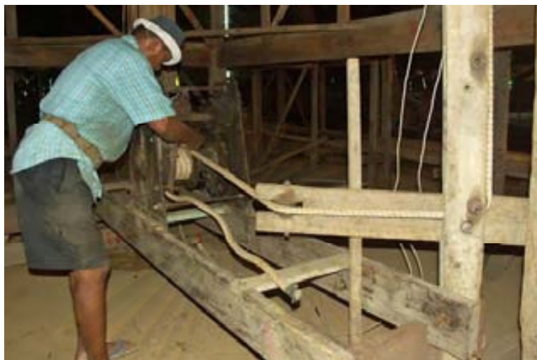
ภาพที่ 4.2.2.3.19 ช่างเมรุวัดประดิษฐ์นารามกำลังทำการติดตั้งเพลาที่จะใช้ในการชักรอก
