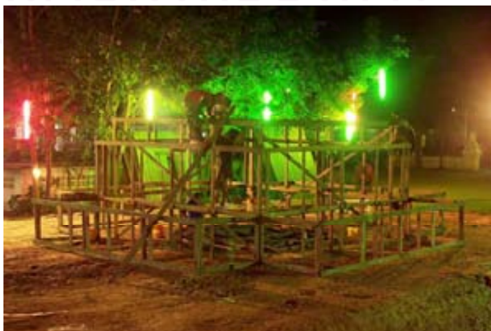
ภาพที่ 4.1.3.3.1 ข่างเมรุวัดพระทรงกำลังช่วยกันติดตั้งแผงฐาน
