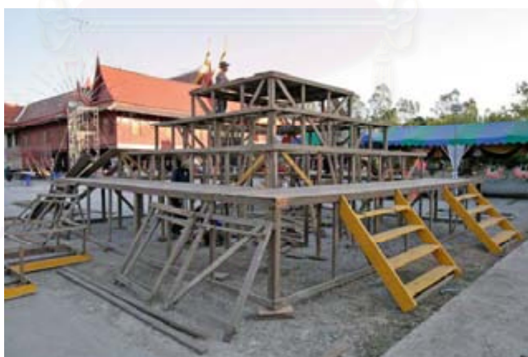
ภาพที่ 4.2.1.3.3 ช่างเมจวัดเกาะกำลังช่วยกันประกอบโครงสร้างส่วนฐาน
