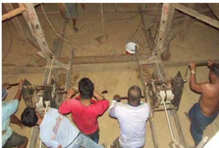
ภาพที่ 4.2.2.3.20 ช่างกำลังช่วยกันออกแรงหมุนเพลายกส่วนยอดของเมรุประธานขึ้น
