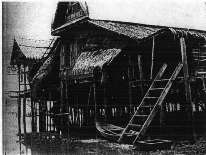
ภาพที่ 82 แสดงลักษณะการยกพื้นเรือนหน้าท่าวมของเรือนไทยภาคกลาง
