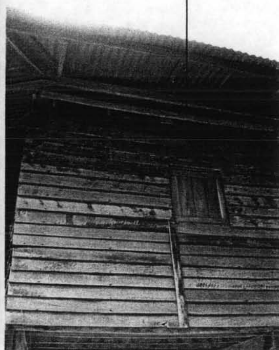
ภาพที่ 88 แสดงลักษณะช่องลมหน้าจั่วเหนือฝาทางเข้าคกเพิง และช่องลมใต้เอวในเรือนกะเหรี่ยงตัวอย่างที่ 4
