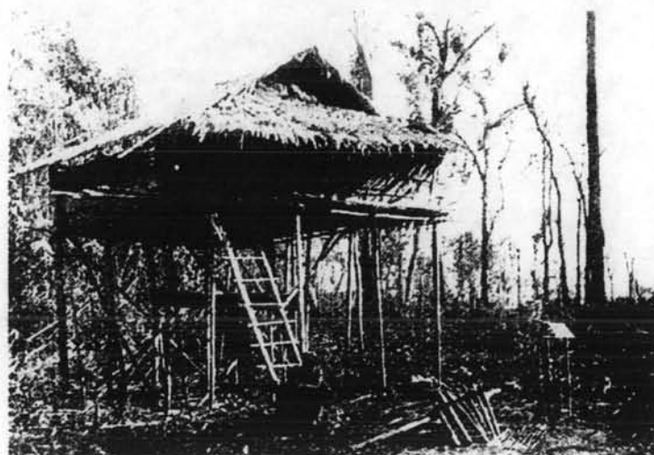
ภาพที่ 83 แสดงลักษณะการยกพื้นเรือนกะเหรี่ยงเพื่อป้องกันสัตว์ร้ายสัตว์ป่ารบกวน
