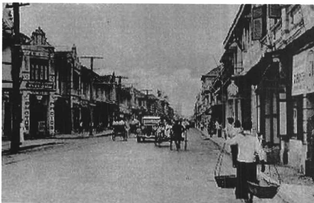
รูปภาพ 4 - 1 รูปแบบอาคารที่สร้างในสมัยรัชกาลที่ 5
