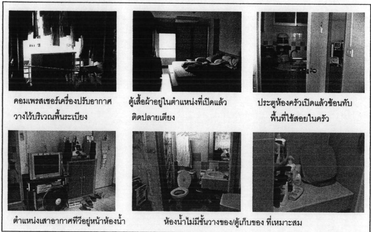
ภาพที่ 7.3 แสดงปัญหาด้านตำแหน่งการใช้งาน
