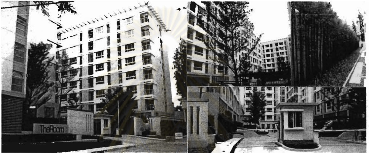
รูปที่ 3.3 บรรยากาศภายในโครงการ
