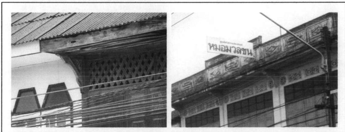
ภาพที่ 5.33 ตัวอย่างรูปแบบค้ายันของอาคารในเขตเทศบาลตำบลห้วยยอด
