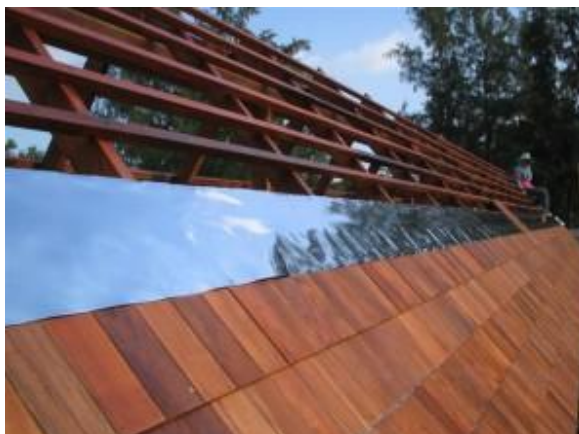
รูปที่ 2.1 แผ่นสะท้อนความร้อน
