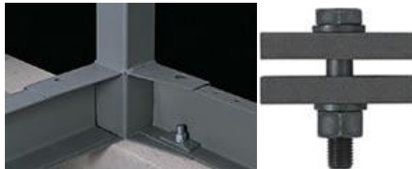
รูปที่ 3.11 จุดเชื่อมต่อของตัวบ้าน และน็อตที่ใช้เชื่อมต่อ
