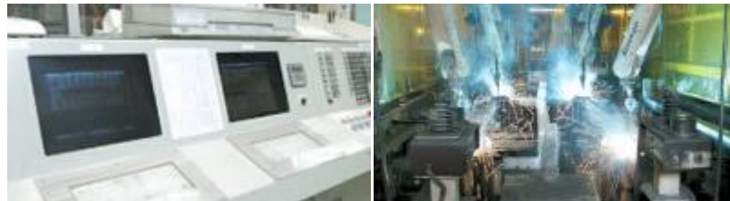
รูปที่ 3.34 ห้องควบคุม
