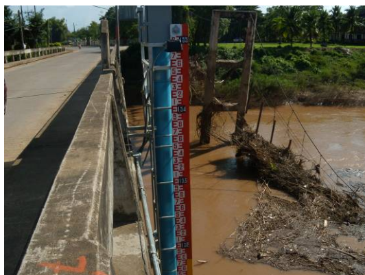
ภาพที่ 4.9 สะพานคอนกรีตที่ใช้ในปัจจุบัน และสะพานแขวนที่ปัจจุบันได้รื้อถอนแล้ว
