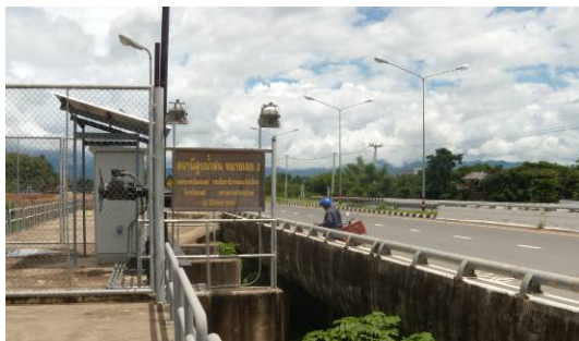
ภาพที่ 4.16 สถานีสูบน้ำริมถนนเชียงใหม่
