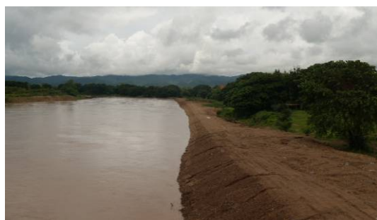
ภาพที่ 4.19 งานขุดลอกแม่น้ำยมของกรมเจ้าท่า (ที่มา : ผู้วิจัย, 2555)
