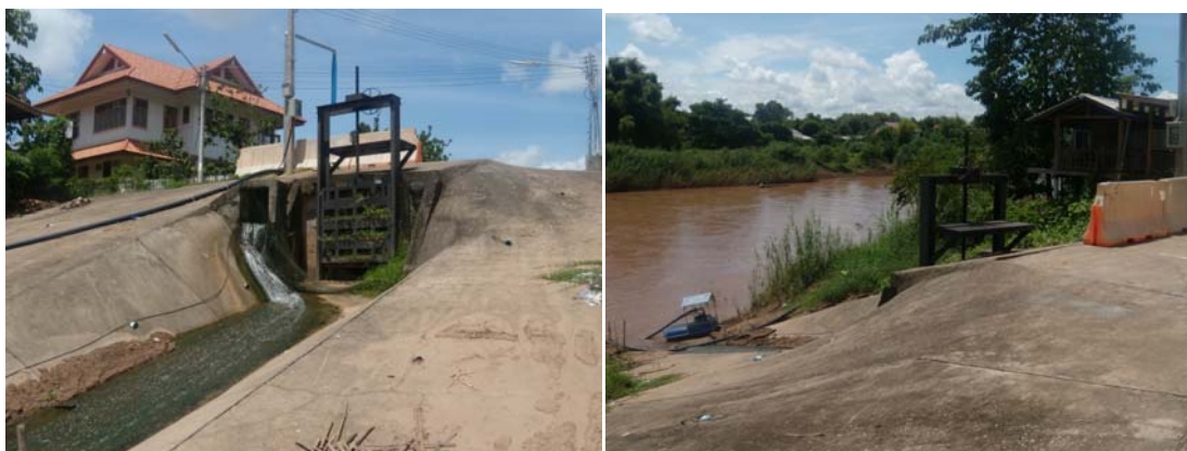
ภาพที่ 4.7 บานเปิดปิดระตุระบายน้ำก่อนไหลลงแม่น้ำน่าน
