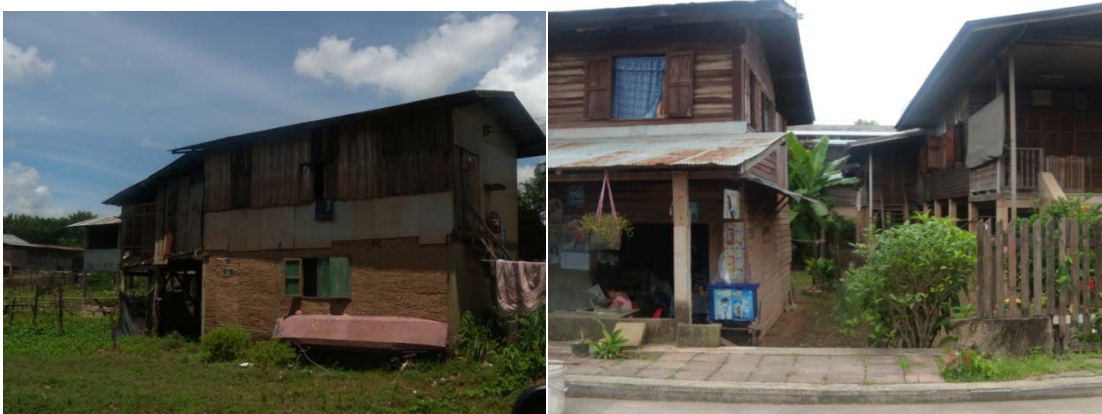
ภาพที่ 5.23 ต่อเติมพื้นที่ใช้สอยบริเวณชั้นใต้ถุน (ชุมชนบ้านภูมินทร์-ท่าลี่) ที่มา : ผู้วิจัย, 2555
