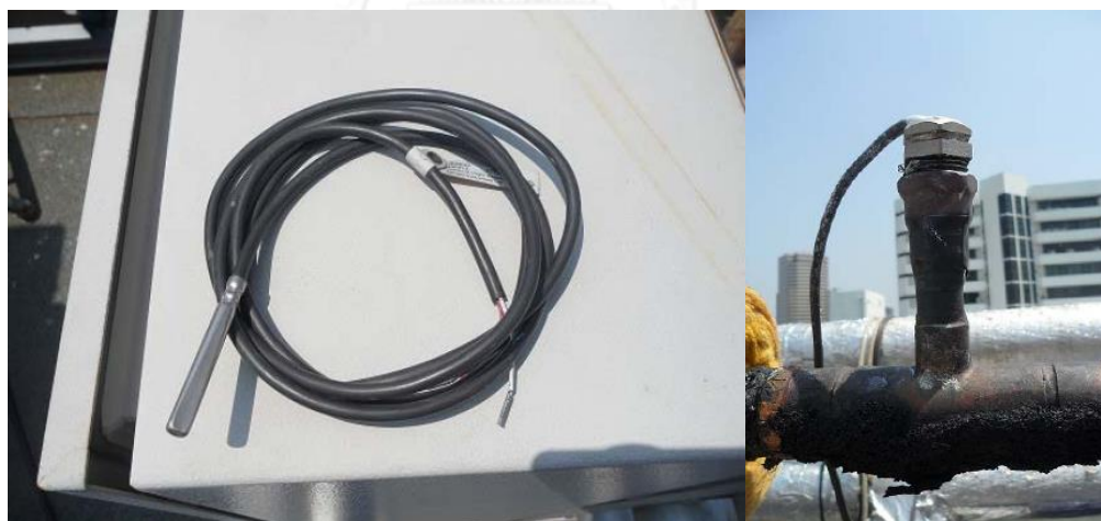
ภาพที่ 3.4 ชุดตรวจวัดอุณหภูมิ และ Pocket สำหรับใส่หัววัด
