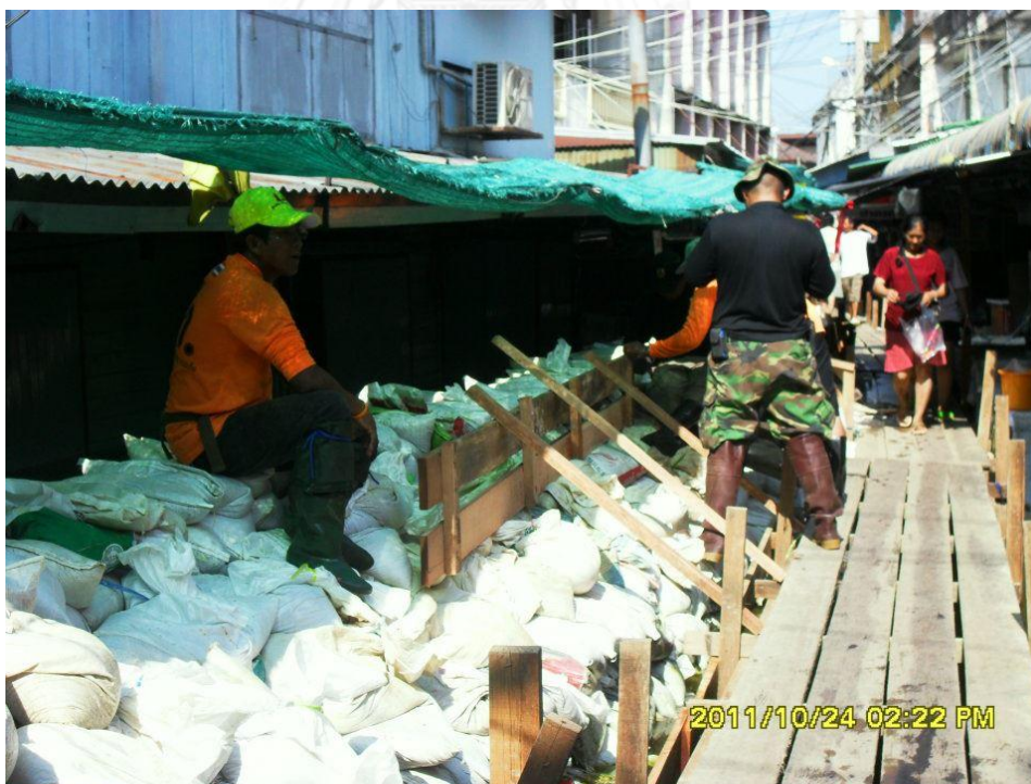
ภาพที่ 18 การสร้างสะพานไม้
