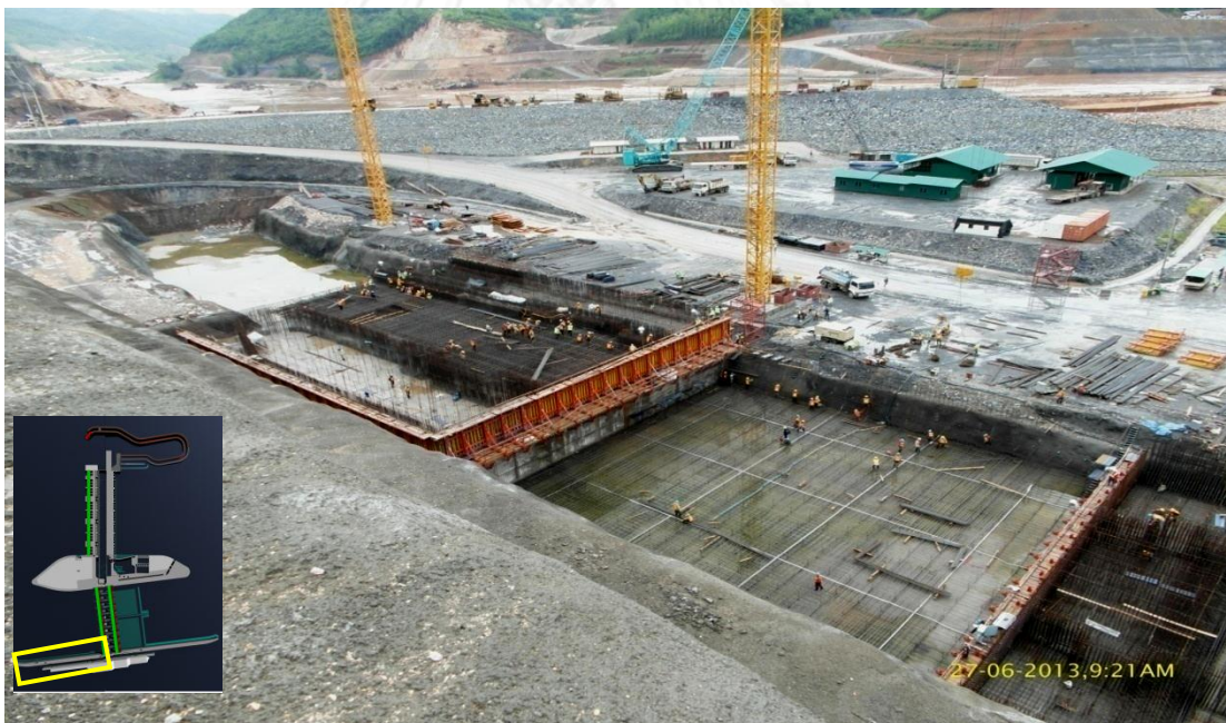
ภาพที่ 4.17 แสดงการก่อสร้างกำแพงเขื่อนไชยะบุรี
