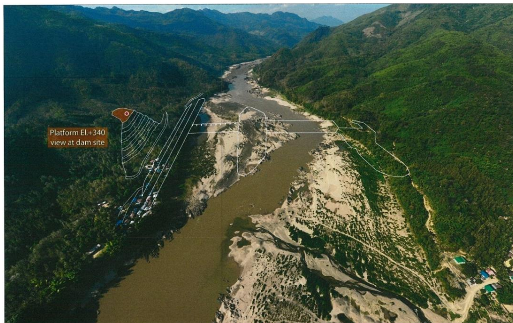
ภาพที่ 4.12 แสดงภาพโดยรวมโครงการไฟฟ้าพลังน้ำไซยะบุรีก่อนทำการก่อสร้าง
