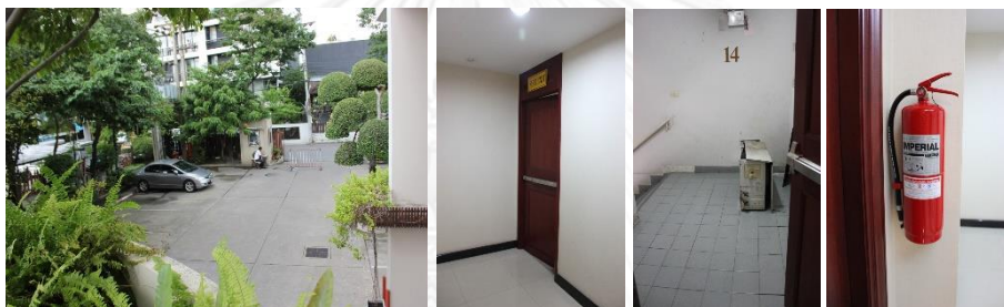
ภาพที่ 120 แสดงระบบรักษาความปลอดภัย ทางออกฉุกเฉิน และอุปกรณ์ป้องกันอัคคีภัย
