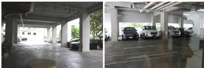
ภาพที่ 27 แสดงที่จอดรถด้านหน้า (ซ้าย) และด้านหลังของอาคารอยู่อาศัยรวม (ขวา)
