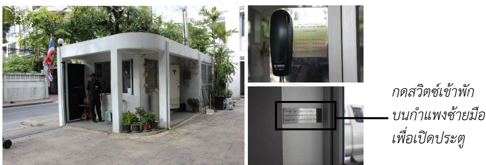
ภาพที่ 101 แสดงระบบรักษาความปลอดภัย และเครื่องโทรศัพท์ที่ติดต่อก่อนเข้าตัวอาคาร
