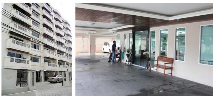
ภาพที่ 31 แสดงลักษณะทางกายภาพของอาคารอยู่อาศัยรวม Sirin Place
