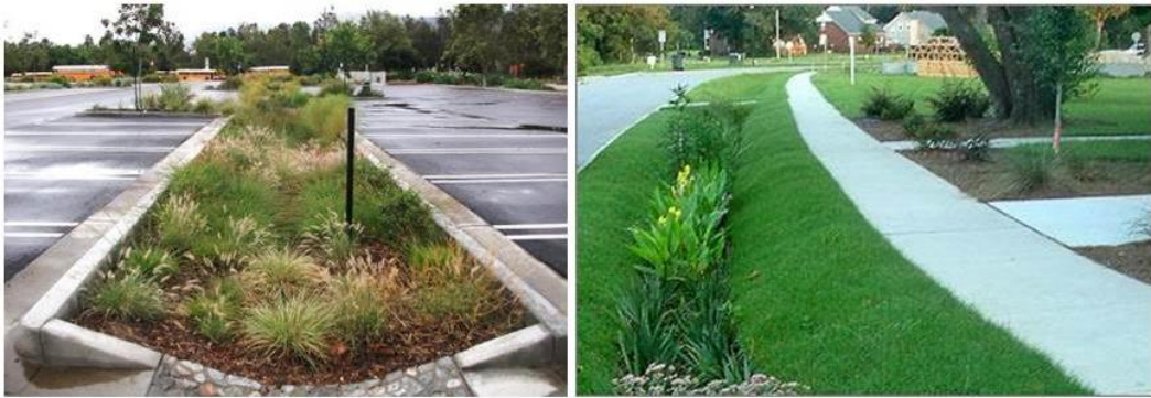
ภาพที่ 5.12 ตัวอย่างของ Bio-Swale ที่ใช้เป็นที่รับน้ำจากบริเวณพื้นที่จอดรถเพื่อช่วยกรองมลพิษที่ไหลรวมกับน้ำฝนบริเวณลานจอดรถ ก่อนปล่อยลงสู่ระบบท่อสาธารณะและแหล่งน้ำธรรมชาติ ที่มา: http://lacreekfreak.wordpress.com (26 มีนาคม 2557)
