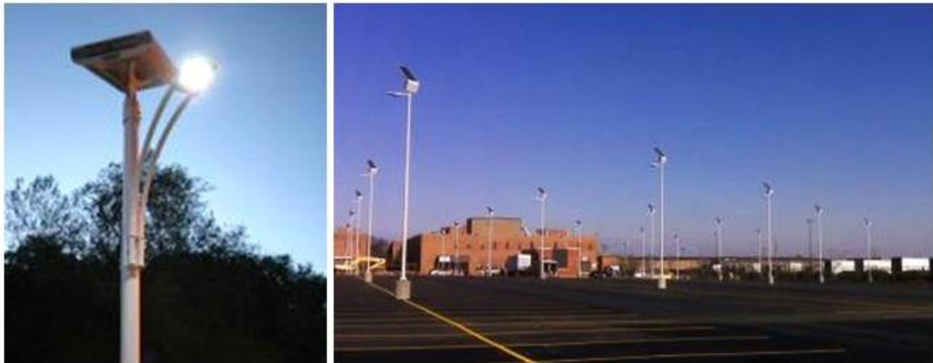
ภาพที่ 5.10 การให้แสงสว่างบริเวณพื้นที่จอดรถจากพลังงานแสงอาทิตย์ ที่มา : http://www.ledsmagazine.com (1 พฤษภาคม 2557)
