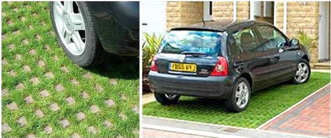
ภาพที่ 5.14 ตัวอย่างลานจอดรถปูพื้นด้วยวัสดุพื้นผิวที่น้ำสามารถซึมผ่านได้ ที่มา : http://www.livinglandscapes.uk.com/PermeableDriveways.shtml (10 พฤษภาคม 2557)
