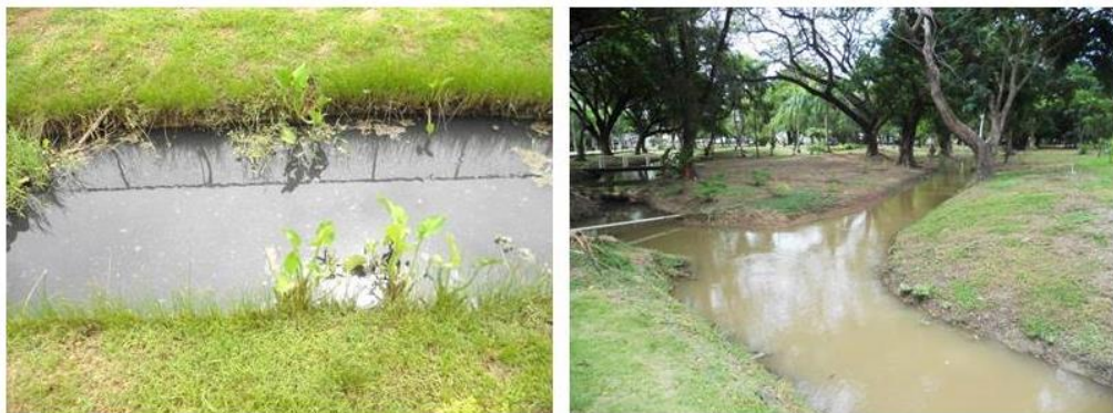
ภาพที่ 5.13 ตัวอย่างของ Bio-Swale ที่ใช้เป็นที่รับน้ำและระบายน้ำฝนก่อนปล่อยลงสู่ระบบท่อสาธารณะและแหล่งน้ำธรรมชาติ ที่มา : สถาบันเทคโนโลยีแห่งเอเชีย(Asian Institute of Technology)
