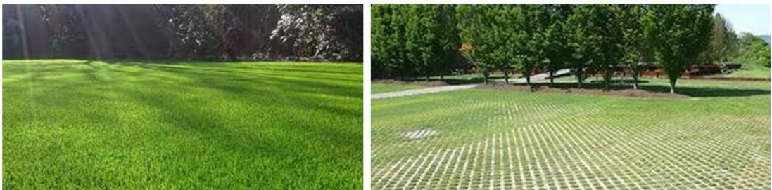
ภาพที่ 5.15 ตัวอย่างพื้นที่ปกคลุมด้วยพืชพรรณ และพื้นที่ลานกิจกรรมที่ปูพื้นด้วยบล็อกคอนกรีตมีรูพรุนซึ่งเป็นพื้นผิวที่น้ำสามารถซึมผ่านได้ ที่มา : http://www.gorich.hk (1 พฤษภาคม 2557)
