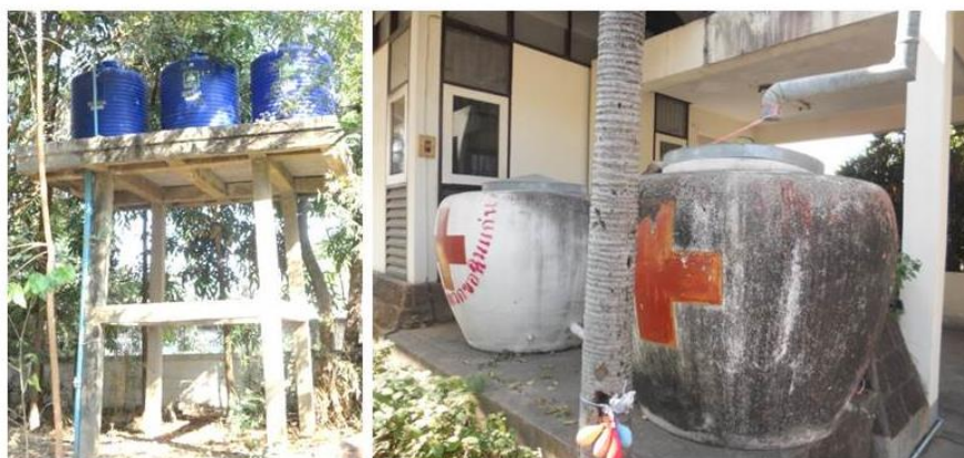
ภาพที่ 5.4 ถังเก็บน้ำบาดาลและถังเก็บน้ำฝนเพื่อนำมาใช้ในการรดน้ำต้นไม้ภายในหน่วยงานของศูนย์ราชการจังหวัดขอนแก่น
