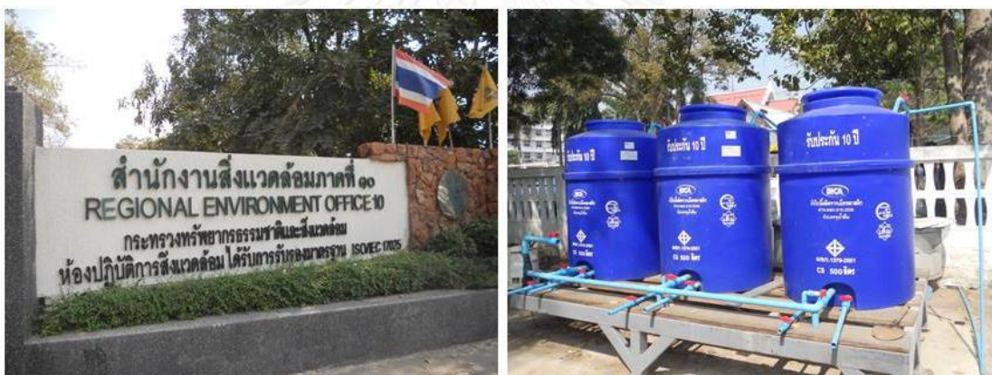
ภาพที่ 5.18 ระบบกำจัดขยะอินทรีย์ด้วยถังหมักขยะอินทรีย์ ของสำนักงานสิ่งแวดล้อมภาคที่ 10
