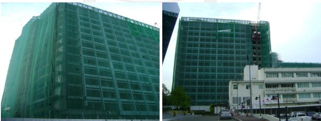
ภาพที่ 44 แสดงการป้องกันฝุ่นและเศษวัสดุตกจากที่สูง
