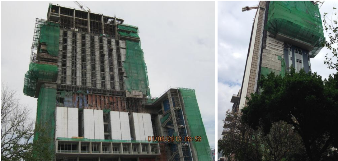
ภาพที่ 24 แสดงการป้องกันฝุ่นและเศษวัสดุตกจากที่สูง
