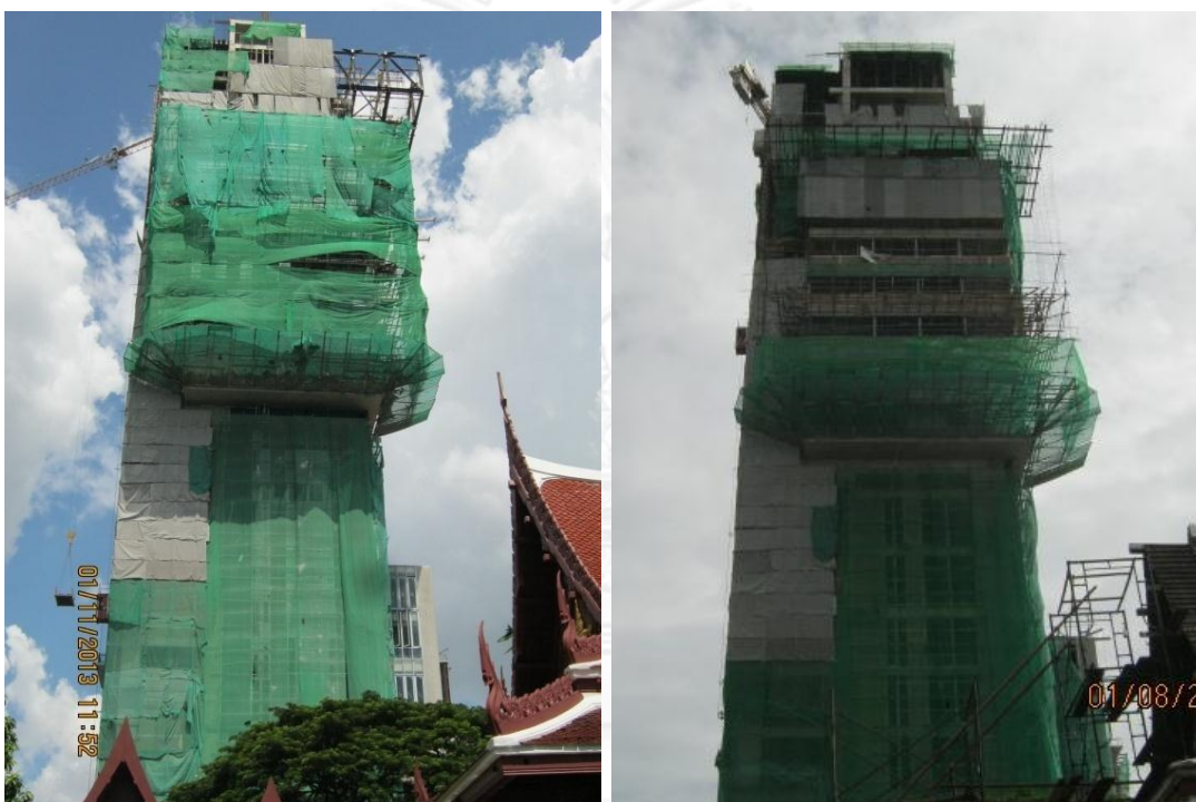
ภาพที่ 23 แสดงการป้องกันฝุ่นและเศษวัสดุตกจากที่สูง
