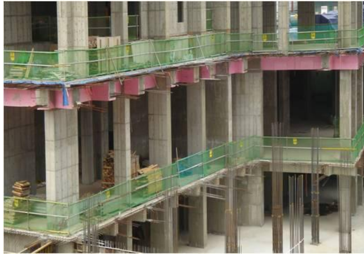
ภาพที่ 4 แสดงการติดตั้งราวกันตกรอบสันของอาคาร ที่มา: ความปลอดภัยในการทำงาน
