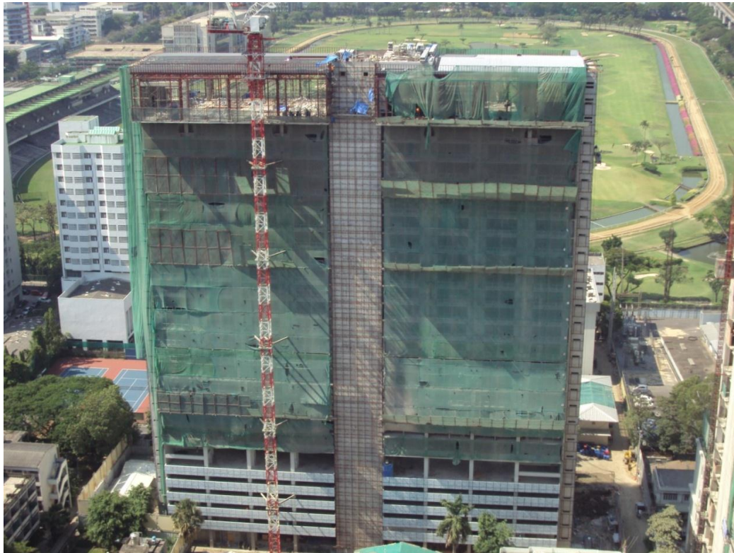
ภาพที่ 33 แสดงการป้องกันฝุ่นและเศษวัสดุตกจากที่สูง
