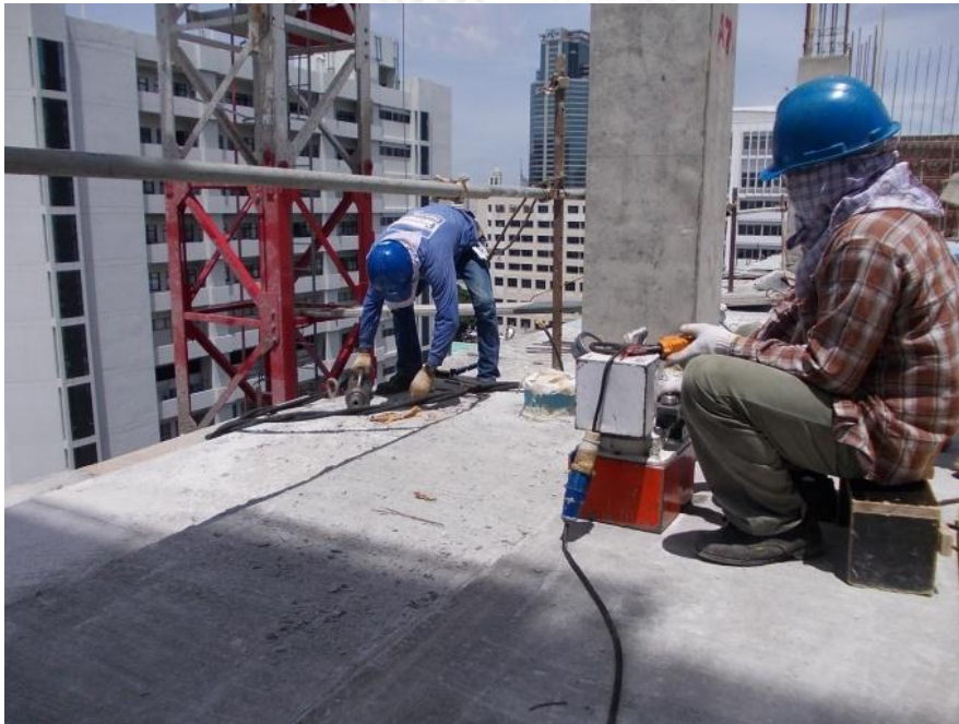
ภาพที่ 38 ราวกันตกเพื่อป้องกันการตกของคน
