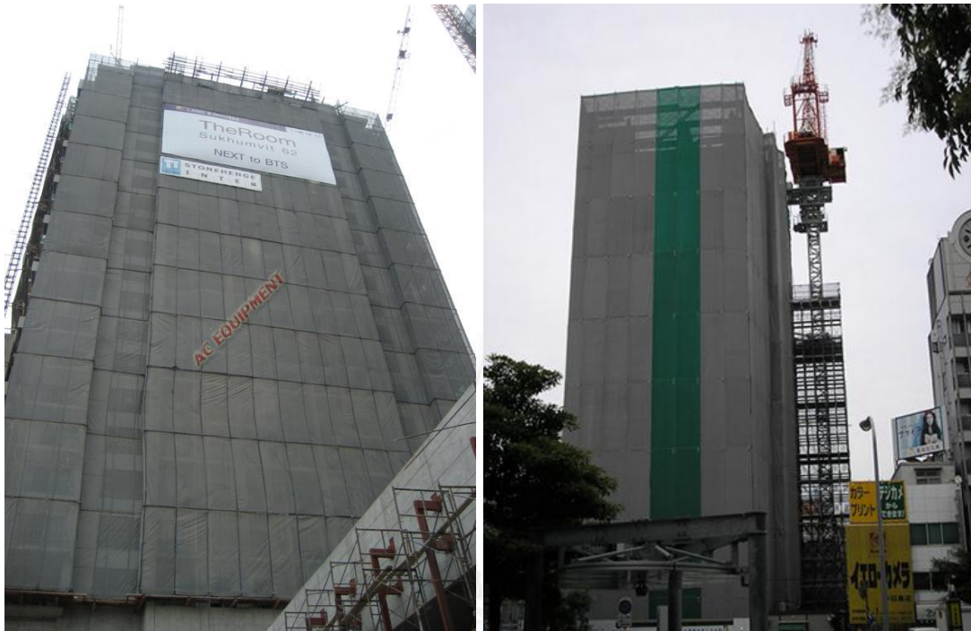
ภาพที่ 7 แสดงการติดตั้งตาข่ายป้องกันฝุ่นและเศษวัสดุตกหล่นรอบอาคาร ที่มา: ความปลอดภัยในการทำงาน
