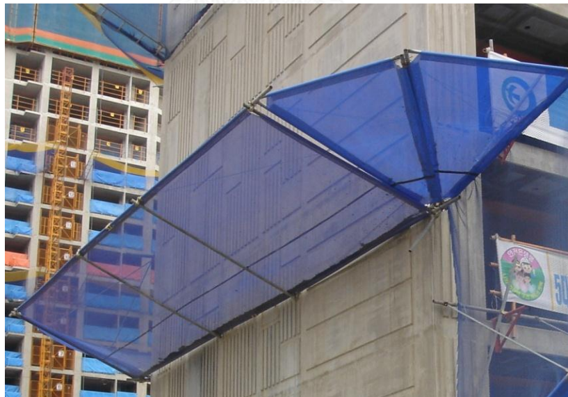
ภาพที่ 8 แสดงการติดตั้งตาข่ายป้องกันเศษวัสดุตกหล่น ที่มา: ความปลอดภัยในการทำงาน
