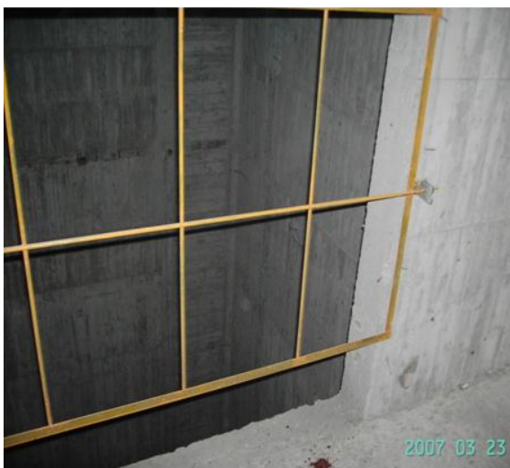
ภาพที่ 6 แสดงการปิดกั้น ช่องลิฟท์ของอาคาร
