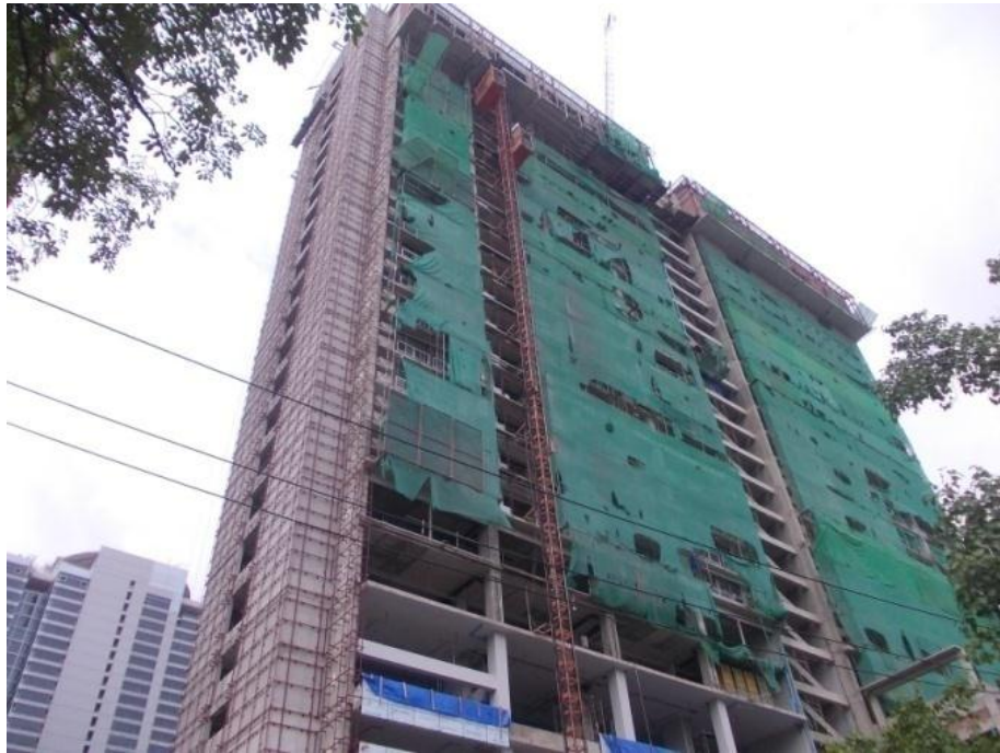
ภาพที่ 35 แสดงการป้องกันฝุ่นและเศษวัสดุตกจากที่สูง
