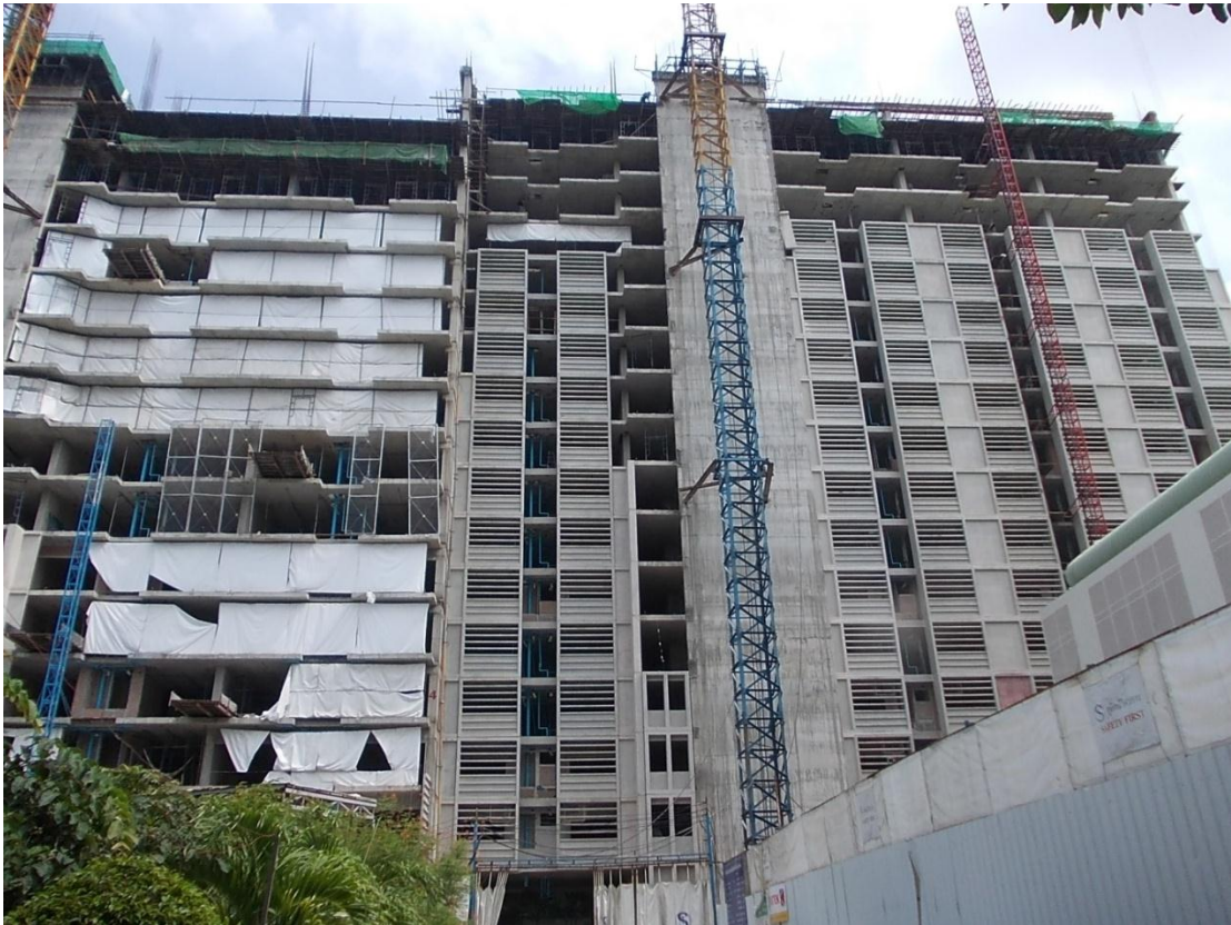
ภาพที่ 52 แสดงการป้องกันฝุ่นและเศษวัสดุตกจากที่สูง
