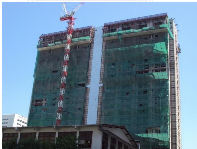
ภาพที่ 34 แสดงการป้องกันฝุ่นและเศษวัสดุตกจากที่สูง
