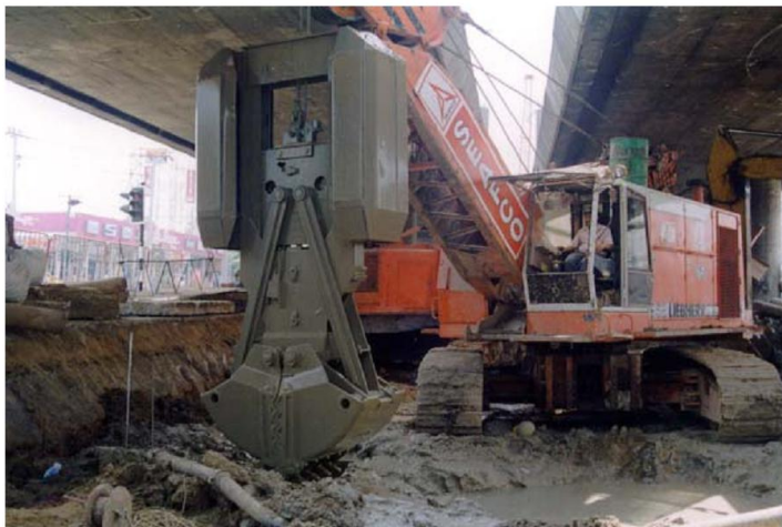
รูปที่ 2.1-12 การขุดเจาะเสาเข็มเจาะแบบสตีลเหล็ยม (barrette) ภายใต้ความสูงจำกัด (ณรงค์และคณะ, 2542)
