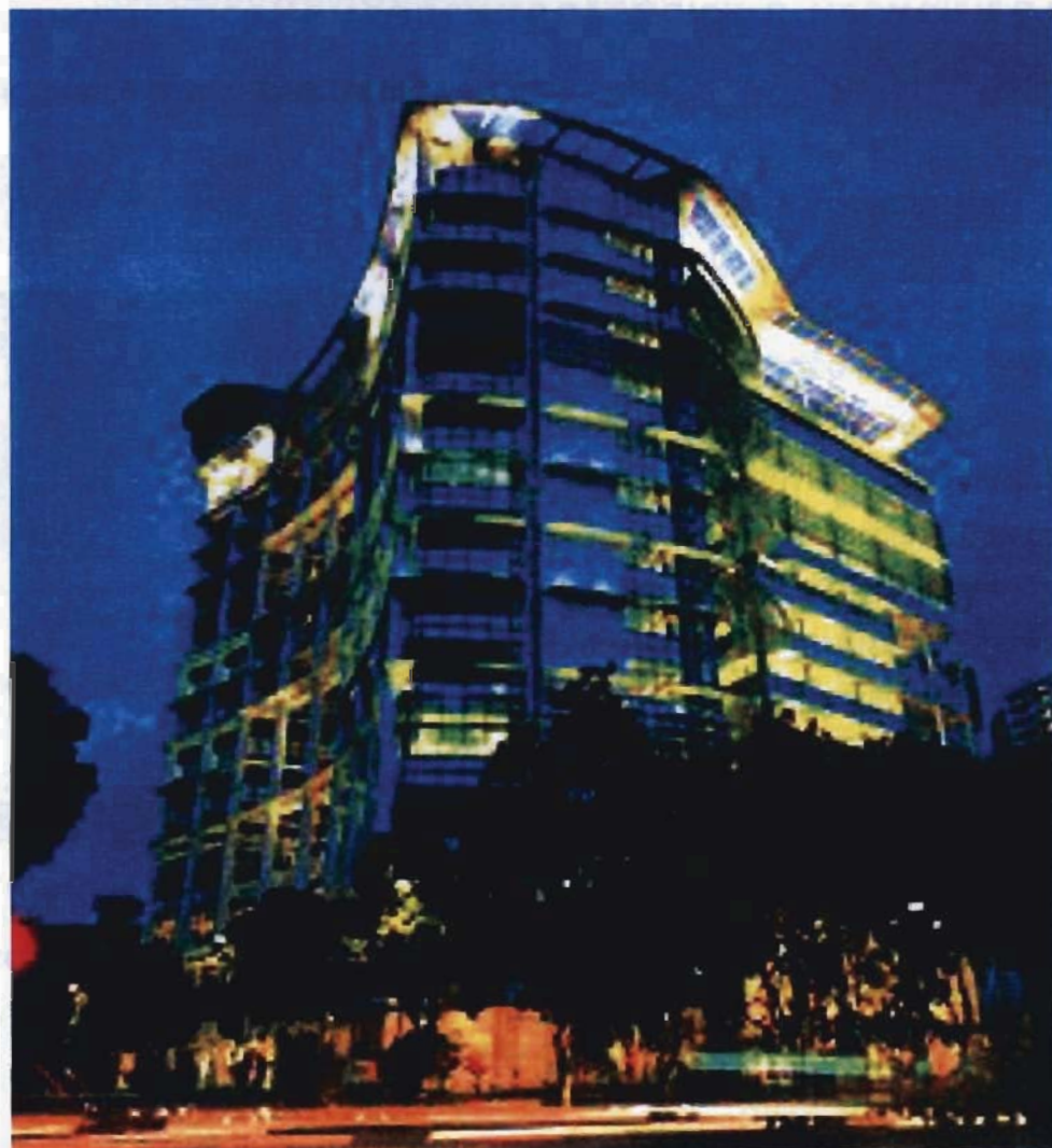
ภาพที่ 31 อาคารหอสมุดแห่งชาติ ประเทศสิงคโปร์ รางวัลรองอันดับหนึ่งระดับอาเซียน ปี 2550 (ที่มาภาพ: http://online.wsj.com/article/SB118064860527220566.html )
