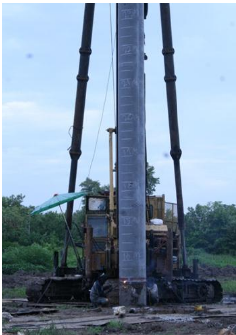
รูปที่ 3-1 ข้างอิงระดับของปลายเสาเข็มขณะตอก
