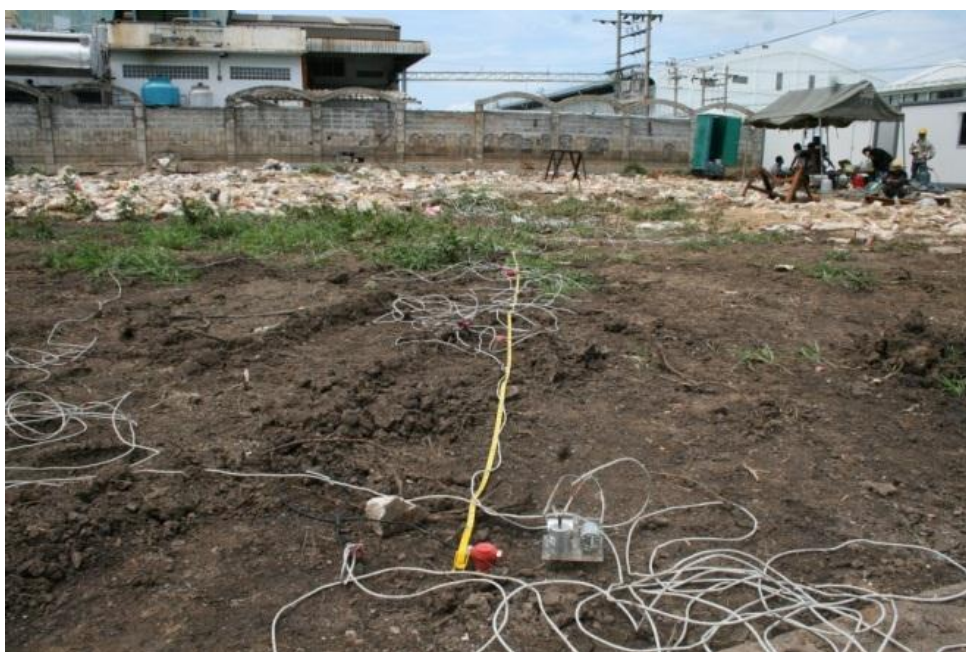
รูปที่ 4-8 การติดตั้ง geophone ที่ระยะทางต่างๆ
