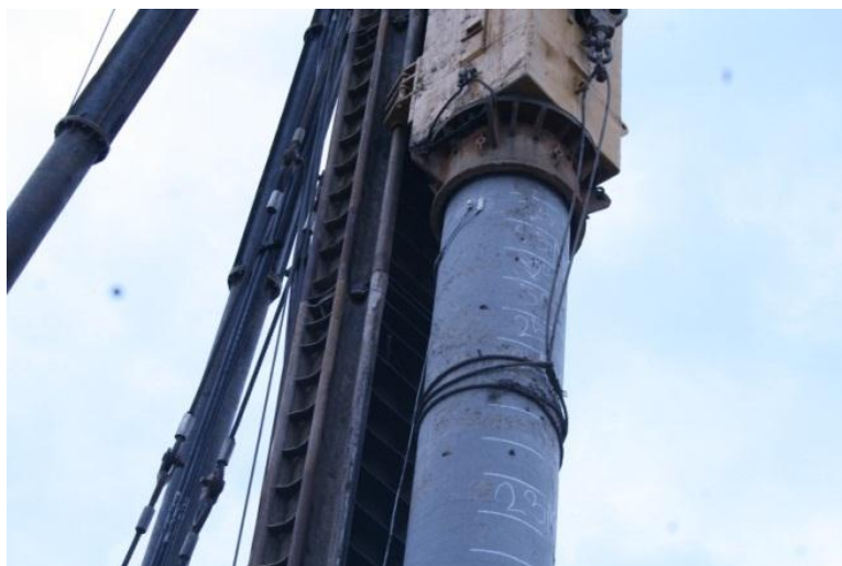
รูปที่ 4-10 การติดตั้งมาตรวัดสัญญาณการทดสอบ PDA บริเวณหัวเสาเข็ม
