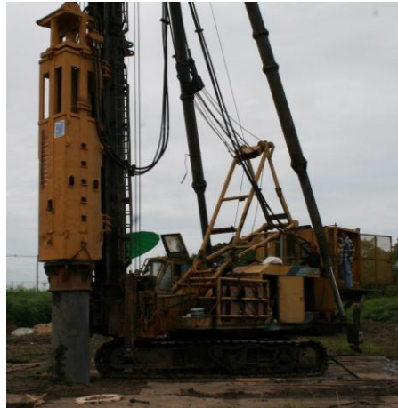
รูปที่ 4-6 เครื่องตอกเสาเข็มไฮดรอลิก(single action hydraulic hammer)
