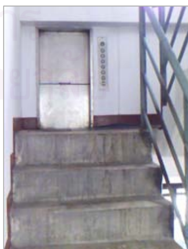
บันไดหนีไฟและลิฟต์ทิ้งขยะ
