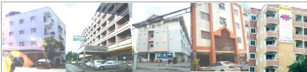
รูปภาพ 3.4 แสดงอาคารกลุ่มที่ 2 ระดับราคาเช่า 3,000-6,000 บาทต่อเดือน
