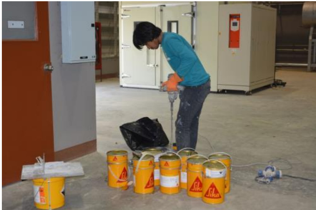
รูปที่ ข-11การเตรียมพอลิเมอร์ในการติดตั้ง
