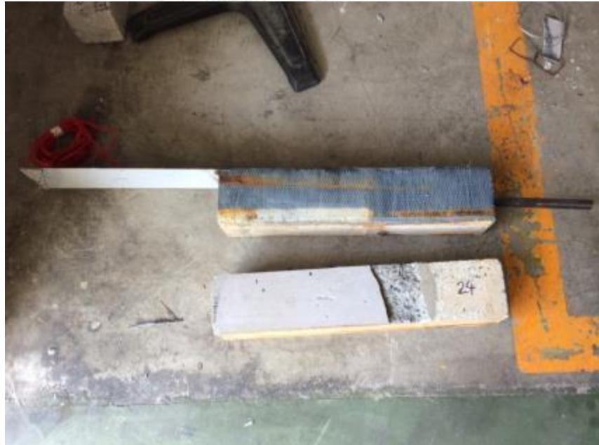
รูปที่ จ-27 การวิบัติที่ตัวอย่างคอนกรีต E24-8
