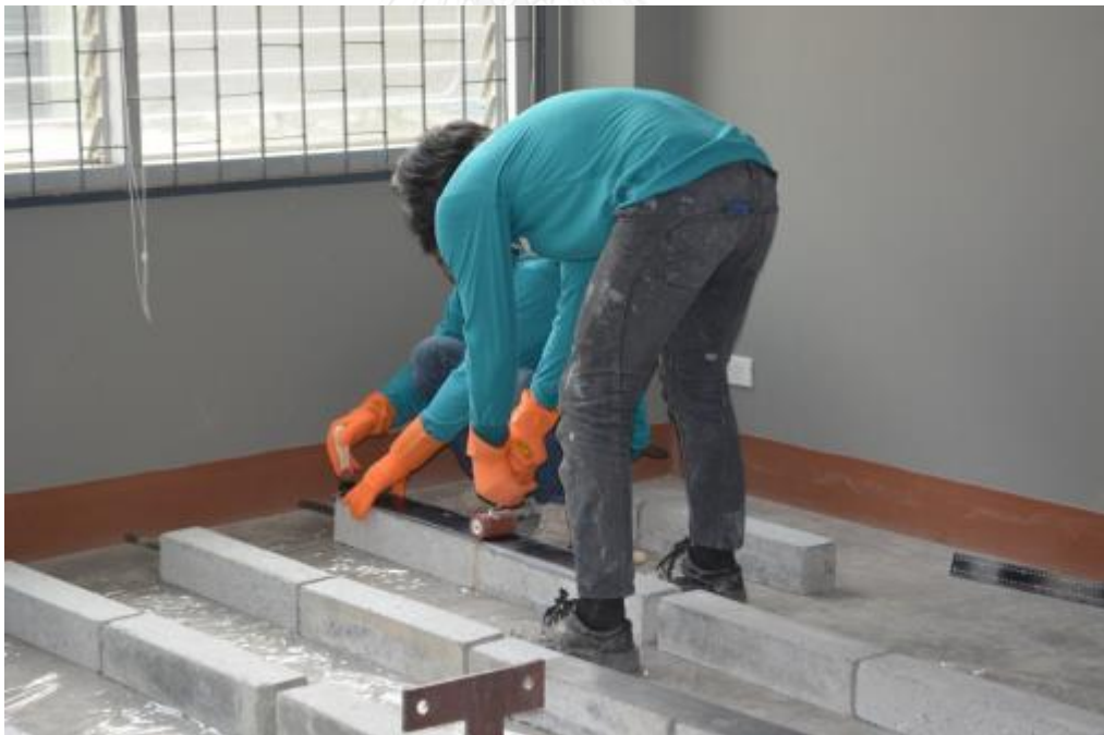
รูปที่ ข-12การติดตั้งCFRPแบบแผ่นบนตัวอย่างคอนกรีต
