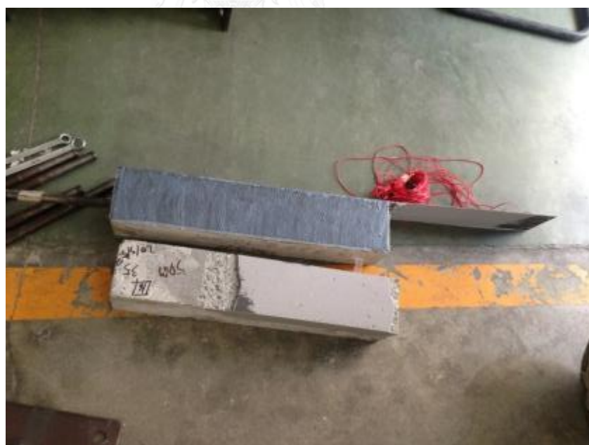
รูปที่ จ-10 การวิบัติที่ตัวอย่างคอนกรีต B35-12
