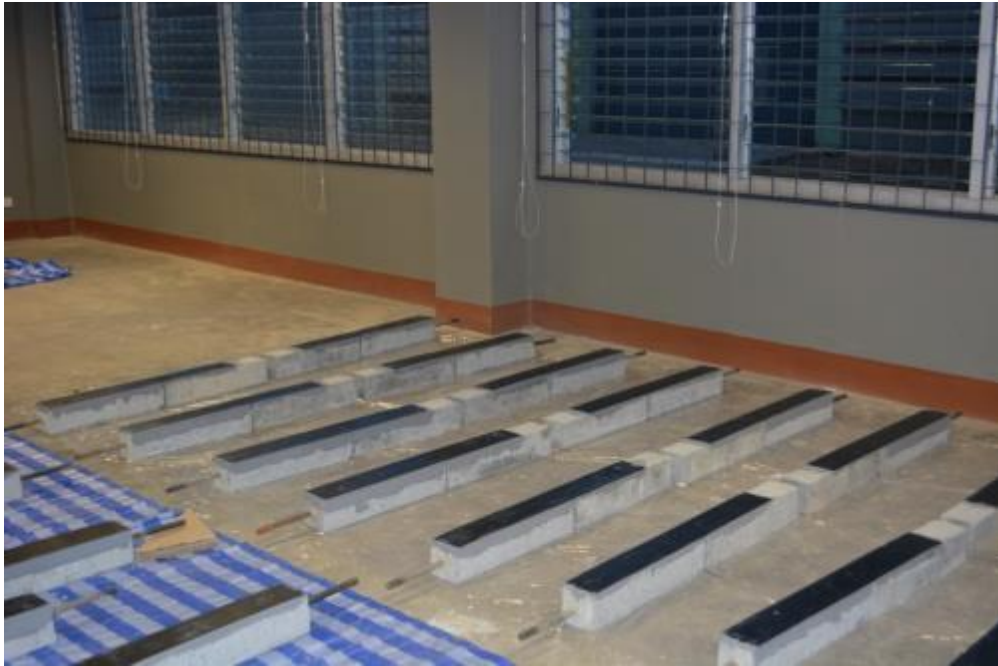
รูปที่ ข-13 ตัวอย่างคอนกรีตหลังติดตั้งCFRP
