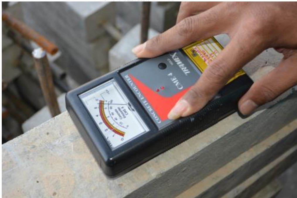
รูปที่ ข-10 วัดความชื้นที่คอนกรีตก่อนการติดตั้งวัสดุพอลิเมอร์เสริมเส้นใย
