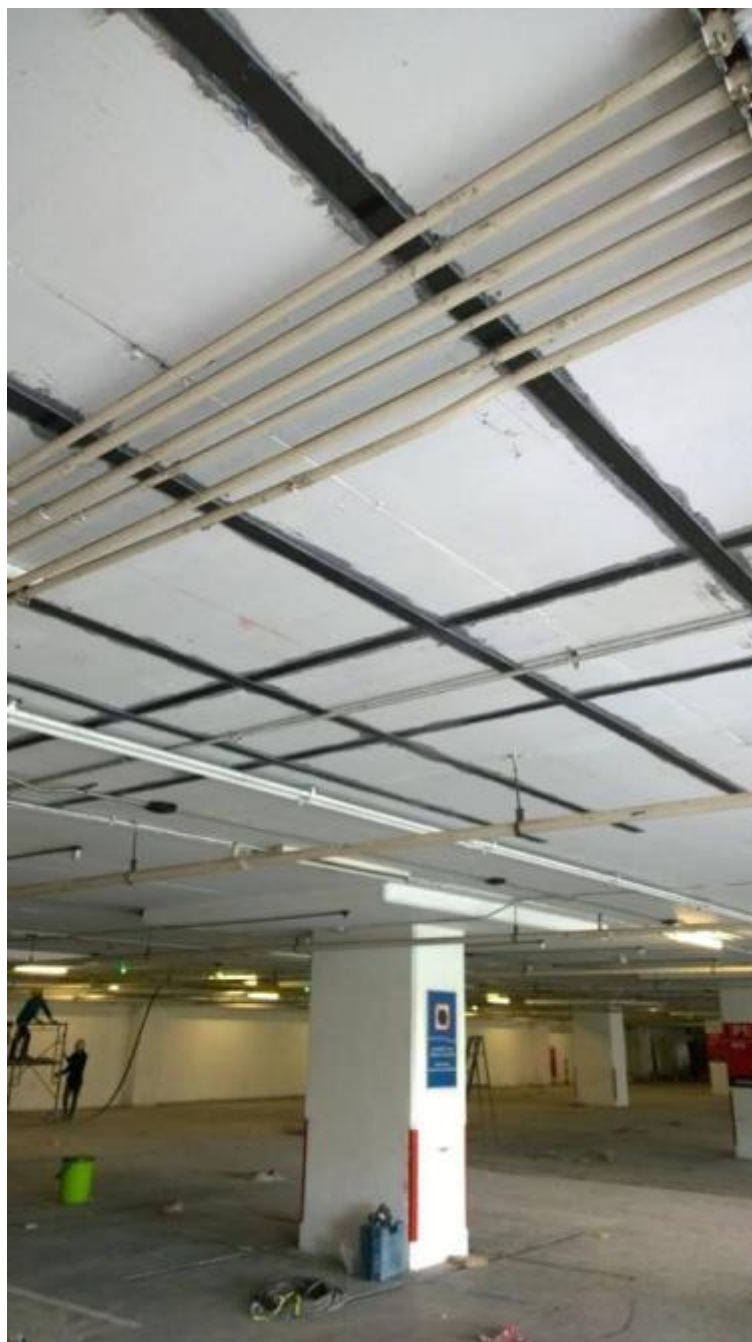
รูปที่ 1.1 การเสริมกำลังด้วยวัสดุพอลิเมอร์เสริมเส้นใยคาร์บอนบนแผ่นพื้นไร้คาน
