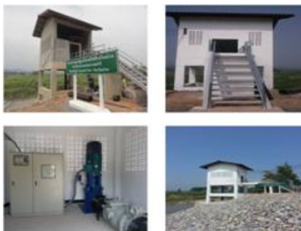
รูปที่ 5.35 สถานีสูบน้ำเพื่อป้องกันอุทกภัย
