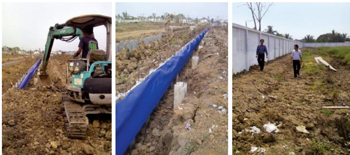
รูปที่ 5.48 แสดงรูปรั้วโครงการที่ติดสวนหรือมีพื้นที่ภายในแคบ
