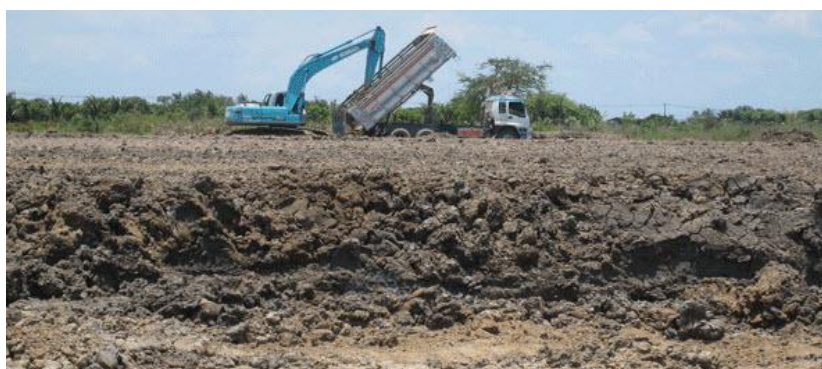
รูปที่ 5.57 แสดงการถมดินภายในโครงการ
