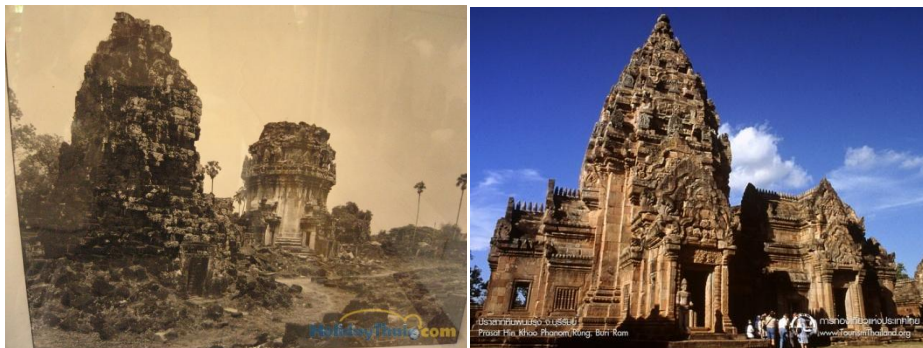
ภาพที่ 2-8 ปราสาทหินพนมรุ้งก่อนและหลังการบูรณะด้วยวิธีอนัสติโลซิส
