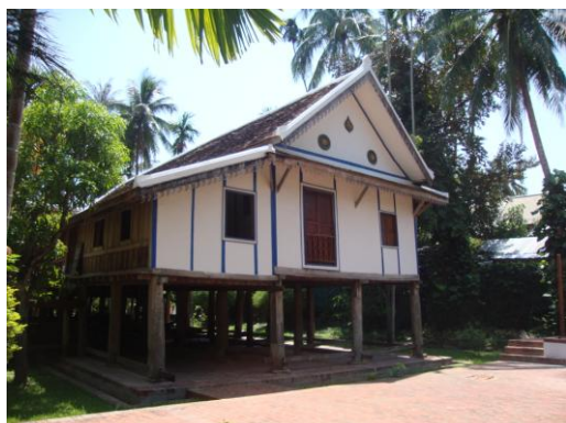
ภาพที่ 5.17 เรือนพื้นดินผนังตอกซีอิ้นุรักษ์ และวิธีในการทำผนังโดยใช้ประทรายทำด้วยหนังกวายโบก ทั้งสองด้านทับผนังไม้ไผ่
