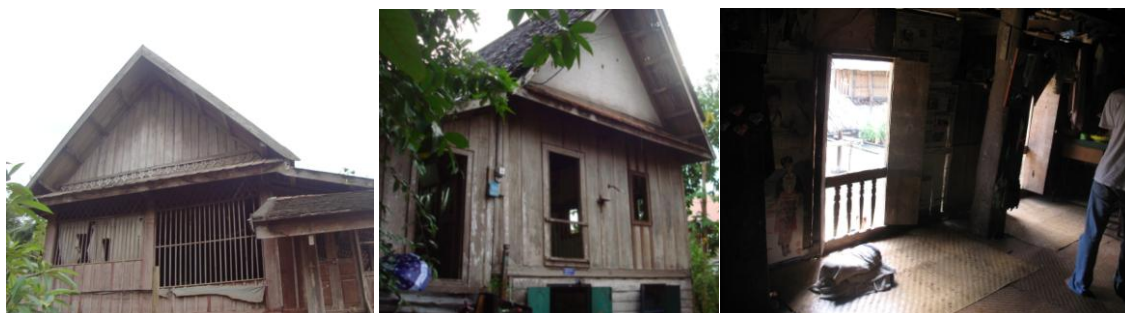
ภาพที่ 5.26 ภาพแสดงลักษณะสัดส่วนของช่องเปิดเมื่อเทียบกับผนังเรือน
