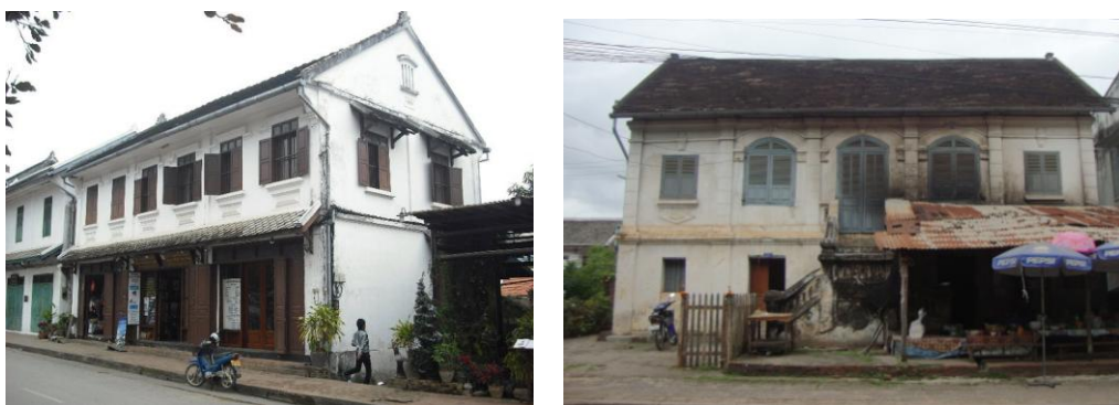
ภาพที่ 5.18 ลักษณะของอาคารที่ใช้วัสดุก่ออิฐ บ้านทาดหลวง เมืองหลวงพระบาง
