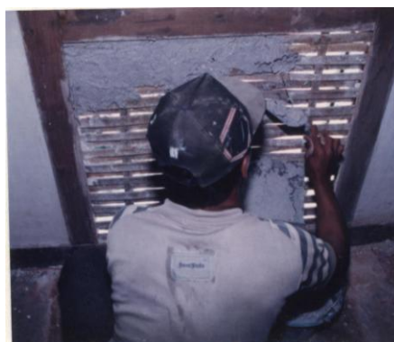
ภาพที่ 5.17 เรือนพื้นดินผนังตอกซีอิ้นุรักษ์ และวิธีในการทำผนังโดยใช้ประทรายทำด้วยหนังกวายโบก ทั้งสองด้านทับผนังไม้ไผ่
