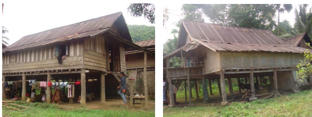
ภาพที่ 5.22 การใช้วัสดุมุงหลังคาด้วยสังกะสี ของเรือนพื้นดินในบ้านชาติ จังหวัดหลวงพระบาง
