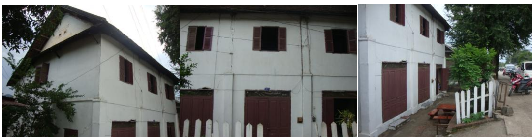
ภาพที่ 4.27 รูปภาพภายนอกอาคารของเรือนป่าคำแพง
