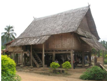
ภาพที่ 5.20 ภาพแสดงการใช้วัสดุเมงด้วยไม้ไผ่ และโครงสร้างหลังคา
