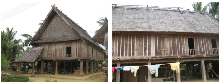
ภาพที่ 5.15 ลักษณะของเรือน พื้นถิ่นที่ใช้วัสดุผนังไม้แป้น
