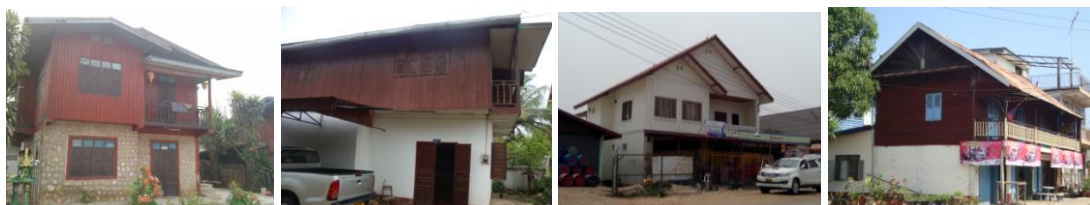
ภาพที่ 5.37 ลักษณะของเรือนที่ปลูกสร้างใหม่ในปัจจุบัน เป็นเรือนก่ออิฐ และปิดล้อมชั้นล่าง
