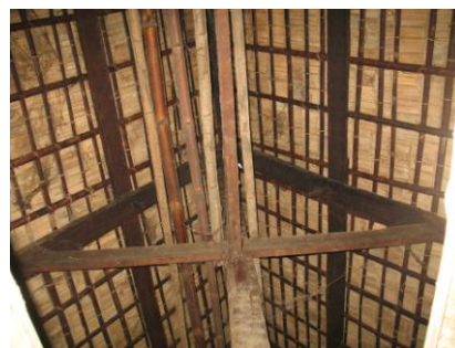
ภาพที่ 5.20 ภาพแสดงการใช้วัสดุเมงด้วยไม้ไผ่ และโครงสร้างหลังคา
