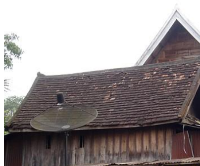
ภาพที่ 5.21 ภาพแสดงการใช้วัสดุเมงหลังคาด้วยไม้แป้นเกล็ด
