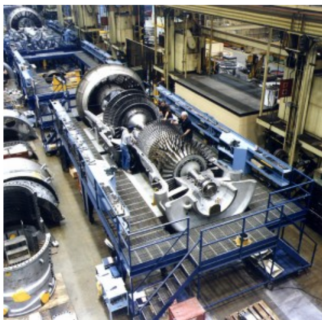
รูปที่ 2.9 เครื่องกำเนิดไฟฟ้ากังหันก๊าซที่ใช้งานจริงในโรงผลิตไฟฟ้า [20]
