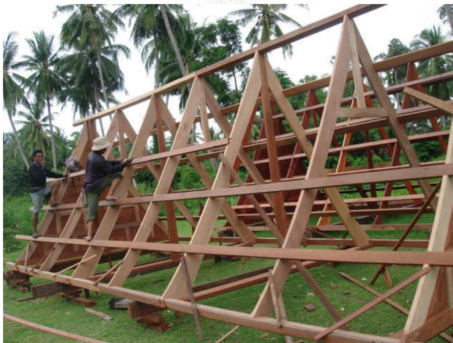
ภาพที่ 26 การปลูกสร้างเรือนไทย การปรุงเครื่องบน (ส่วนหลังคา) เรือนไทย ที่มา. สำนักงานวัฒนธรรมจังหวัดเพชรบุรี (2550, p. 18)
