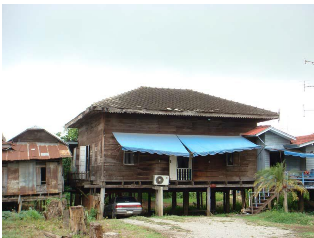
ภาพที่ 13 แสดงการเปลี่ยนแปลงของรูปทรงหลังคาของเรือนไทยที่ได้รับอิทธิพลจากต่างประเทศ ที่มา: สำนักศิลปากรที่ 3 พระนครศรีอยุธยา (2553, p. 7)
