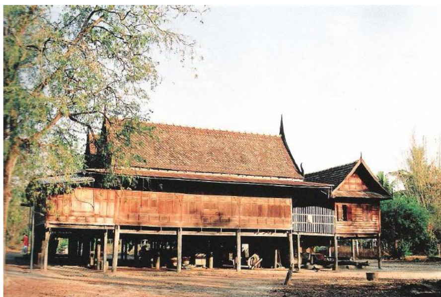
ภาพที่ 7 แสดงภาพเรือนไทยที่เสาสอบเข้ามาตัวเรือน
