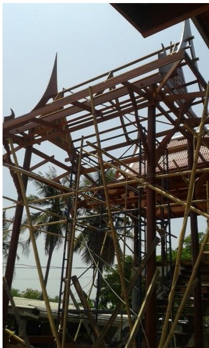
ภาพที่ 23 การปลูกสร้างเรือนไทย การขึ้นโครงเรือน ถ่ายภาพโดยผู้วิจัยเมื่อวันที่ 18 เมษายน 2557
