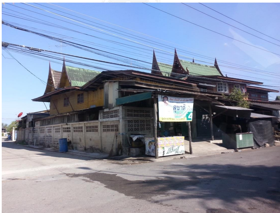
ภาพที่ 30 การปรับเปลี่ยนพื้นที่ใต้ถุนเป็นส่วนใช้สอยอื่นๆ ถ่ายภาพโดยผู้วิจัยเมื่อวันที่ 4 พฤษภาคม 2557
