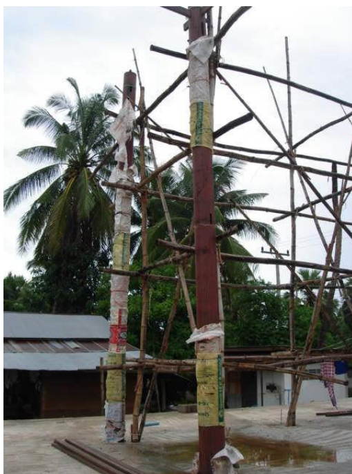
ภาพที่ 25 การปลูกสร้างเรือนไทย การตั้งเสาเอกเรือน ที่มา. สำนักงานวัฒนธรรมจังหวัดเพชรบุรี (2550, p. 18)
