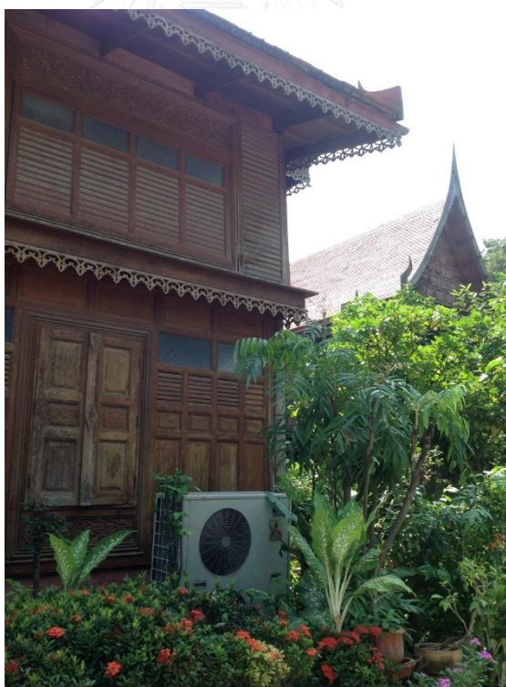
ภาพที่ 28 การปรับเปลี่ยนพื้นที่ใช้สอยของตัวเรือน โดยการนำระบบเครื่องปรับอากาศมาใช้ ถ่ายภาพโดยผู้วิจัยเมื่อวันที่ 3 พฤศจิกายน 2556
