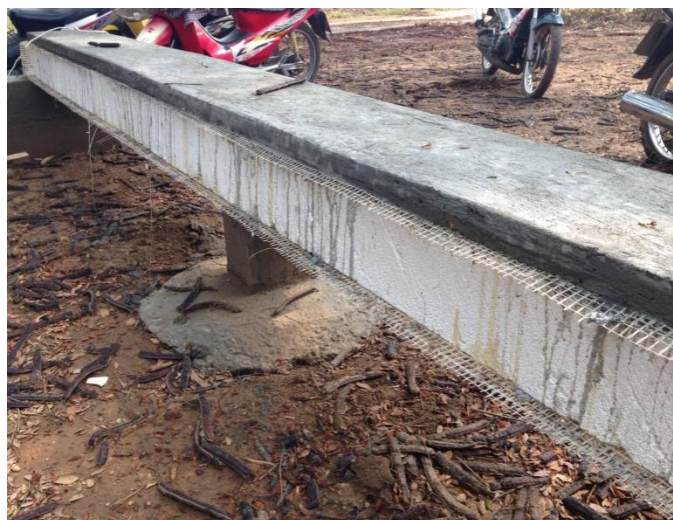
ภาพที่ 4.10 เทคอนกรีต Topping หนา 5 เซนติเมตรบนพื้นประกอบไฟเบอร์กลาส
