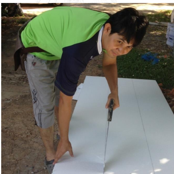
ภาพที่ 4.4 ตัดแผ่นโฟมอีพีเอส เพื่อเป็นส่วนประกอบของพื้น
