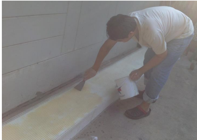
ภาพที่ 4.8 เคลือบอีพ็อกซีเพื่อยึดตาข่ายไฟเบอร์กลาสกับโพลีอีทีเอส
