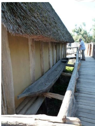
รูปที่ 3 การนำต้นอ้อมามุงหลังคา
