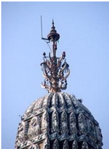
รูปที่ 4.53 ภาพตัวนำล่อฟ้าที่ด้านข้าง ยอดนภศูลเหนือองค์พระปรางค์ใหญ่วัดอรุณฯ [4]
