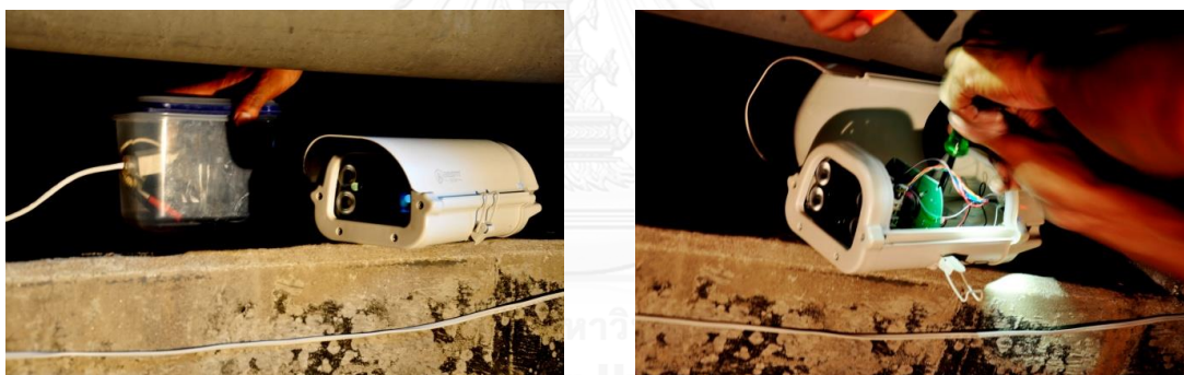
รูปที่ 3.10 การติดตั้งกล้องวงจรปิดบนขอบทางสะพาน
