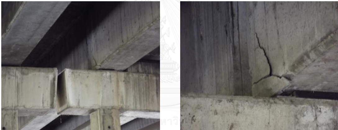
รูปที่ 3.5 ตัวอย่างการเสื่อมสภาพของโครงสร้างส่วนบนพอใช้ระดับ 3
