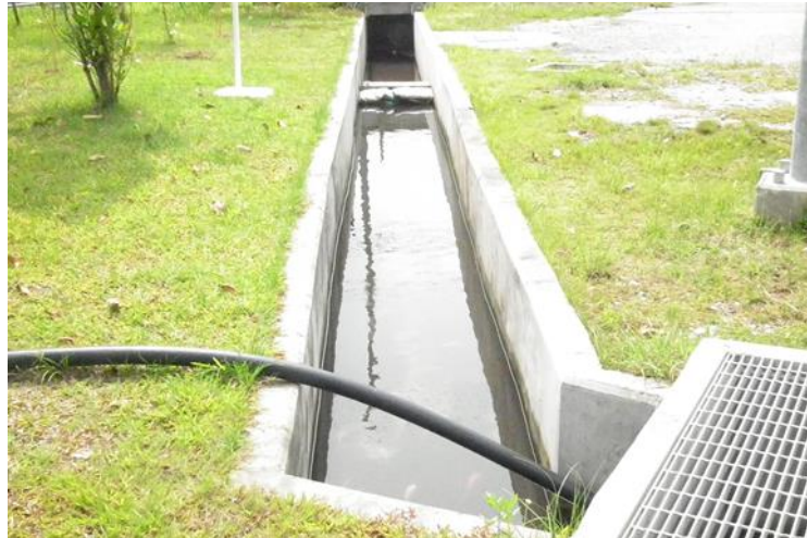
ภาพที่ 5: ท่อลำเลียงน้ำทิ้งของโรงงานภายในนิคมอุตสาหกรรมอมตะนคร
