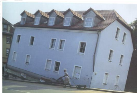
(ข) การวิบัติเนื่องจากการกัดเซาะบริเวณฐานราก (scour of foundation)
