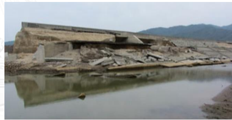
รูปที่ 2.29 (ก) - (ข) ลักษณะของอาคารที่เกิดการวิบัติแบบพลิกคว่ำ ที่เมือง Onagawa ซึ่งมีความสูงของสึนามิ 17.9 เมตร (ค) ลักษณะของอาคารที่มีช่องเปิดขนาดใหญ่ , (ง) ภาพจาก googleMaps/StreetView ก่อนเหตุการณ์สึนามิ (Yeh et al., 2013)
