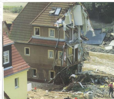
(ก) การวิบัติบริเวณผนังรับแรง (failure of wall)
