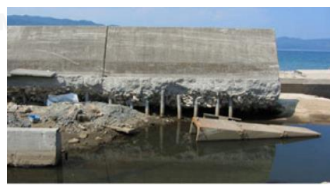
รูปที่ 2.30 ลักษณะการวิบัติของกำแพงกันคลื่นซึ่งเกิดจากการถูกกัดเซาะของฐานราก (Yeh et al., 2013)
