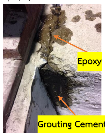
รูปที่ 3.6 วิธีการซ่อมแซมรอยร้าวในคานด้วยวิธี Epoxy Injection
