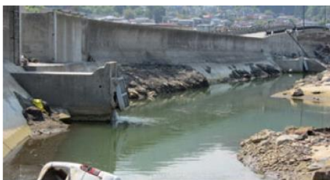
รูปที่ 2.30 ลักษณะการวิบัติของกำแพงกันคลื่นซึ่งเกิดจากการถูกกัดเซาะของฐานราก (Yeh et al., 2013)
