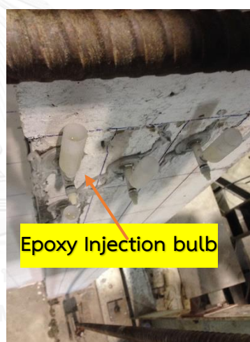
รูปที่ 3.5 วิธีการซ่อมแซมรอยร้าวในเสาด้วยวิธี Epoxy Injection
