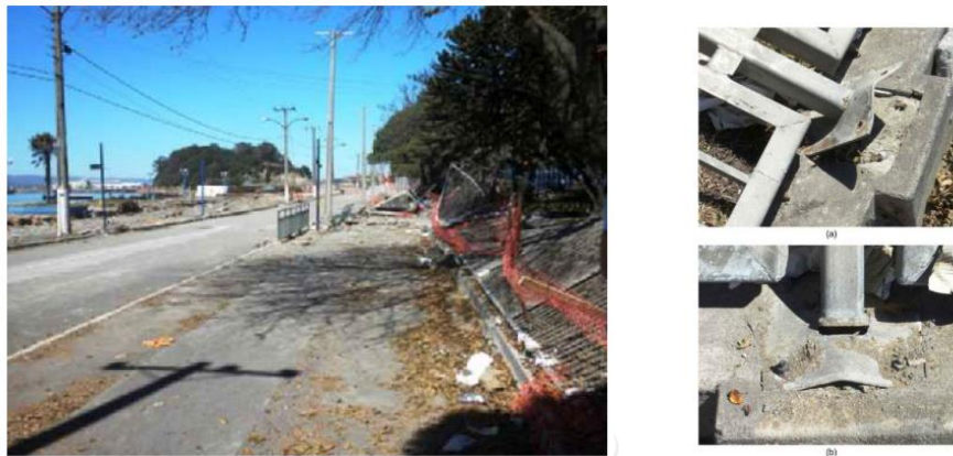
รูปที่ 2.16 โครงสร้างรั้ว และรูปแบบการวิบัติเนื่องจากแรงอุทกพลวัต (Robertson et al., 2012)
