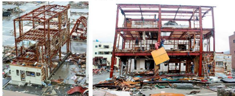
(ก) โครงสร้างเหล็กสูงสามชั้นบริเวณ Onagawa ที่เกิดการวิบัติในขณะน้ำเคลื่อนที่กลับลงทะเล
