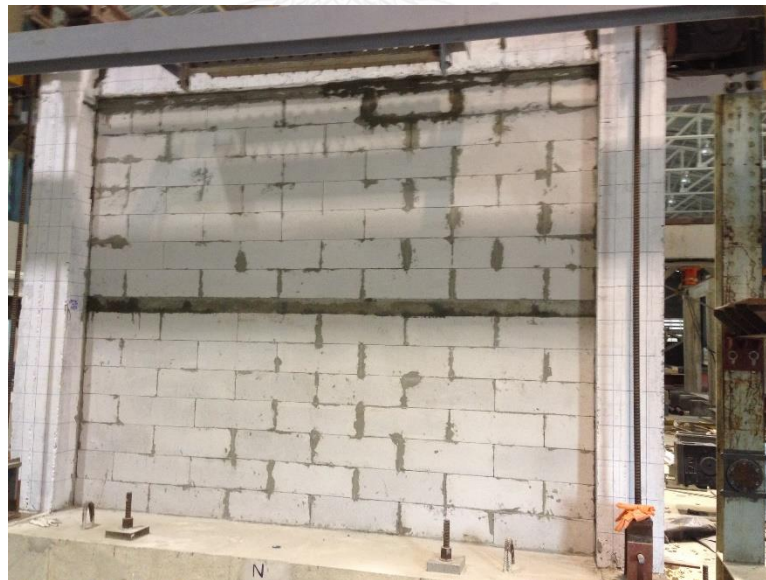
รูปที่ 3.8 โครงข้อแข็งที่มีผนังอิฐมวลเบาก่อนการฉาบปิด
