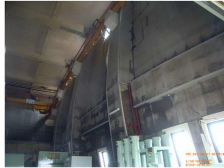
รูปที่ 2.27 โครงสร้างคอนกรีตเสริมเหล็กที่ได้รับความเสียหายเนื่องจากการกระแทกของกำแพงน้ำ (Chock et al., 2013)
