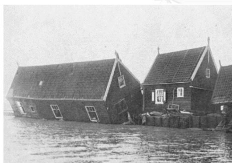
(ข) การวิบัติเนื่องจากการกัดเซาะบริเวณฐานราก (scour of foundation)
