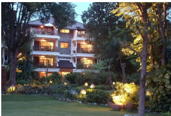
ภาพที่ 5.23 รูปแบบอาคาร ในโรงแรมเบิร์ดส์แอนด์ปีร์รีส์รีสอร์ท
