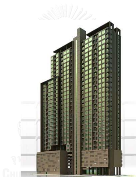
ภาพที่ 4.53 โครงการอาคารชุดอาคารชุดพักอาศัยไฮฟ์ สาทร
