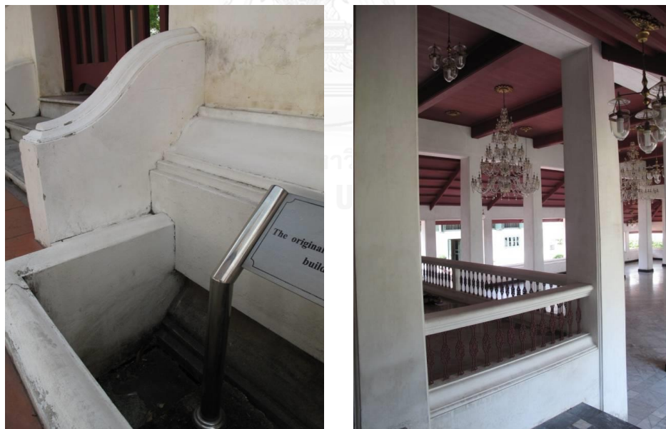
รูปที่ 58 และ รูปที่ 59 ภาพส่วนฐานอาคารของเดิมใต้พื้นซึ่งถูกเว้นให้เห็นเพื่อเปรียบเทียบกับระดับของฐานอาคารปัจจุบันว่ามีระดับต่างกันเล็กน้อย
