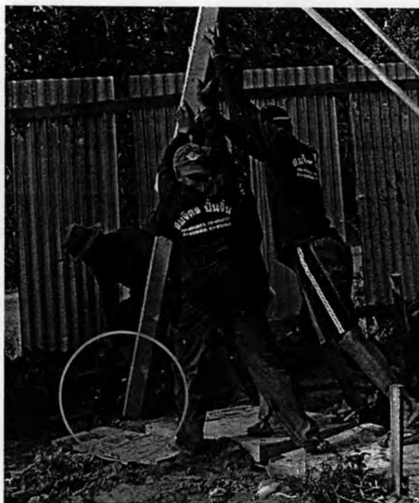
รูปที่ 3.14 แผ่นไม้กระดานสำหรับส่งหัวเข็มลงหลุมที่ขุดเตรียมไว้
