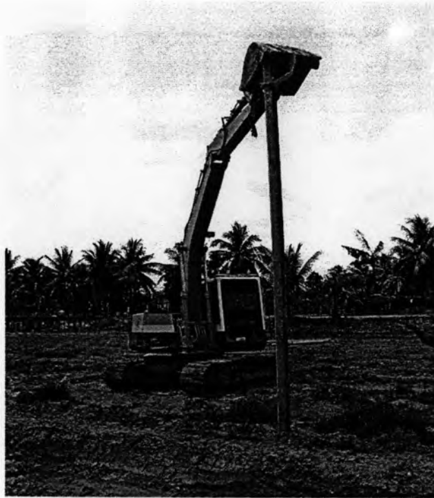
รูปที่ 3.6 การกวดเสาะเข็มของเครื่องจักรขุดดิน
