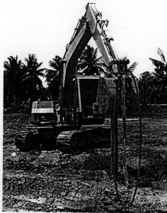
รูปที่ 3.3 อุปกรณ์จับยึดเสาเข็มแบบสลิงผ้า (Cloth Sling)
