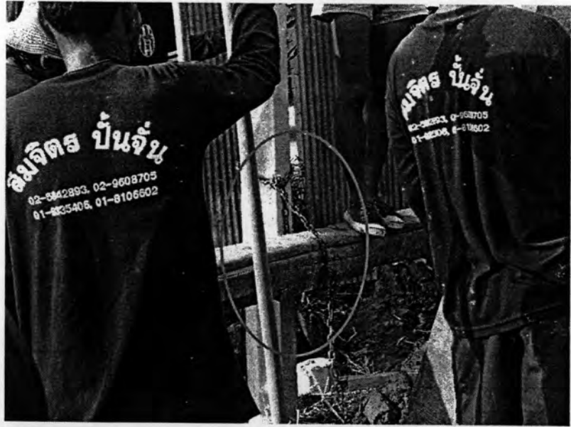
รูปที่ 3.13 การใช้โซ่รัดหัวเข็มเพื่อใช้ยึดไม้ที่ใช้สำหรับยื่นขย่ม
