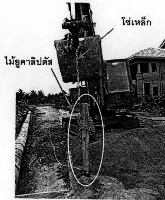
รูปที่ 3.2 ลักษณะอุปกรณ์นำส่งแบบไม้ยูคาลิปตัส และอุปกรณ์จับยึดเสาเข็มชนิดโซ่
