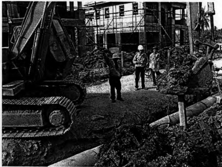
รูปที่ 3.7 การกวดเสาะเข็มให้ได้ระดับตามต้องการ โดยในภาพนั้นใช้ดินภายในกระบะ
