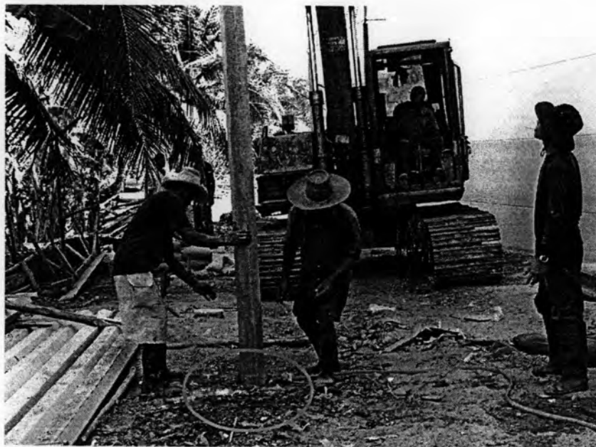
รูปที่ 3.8 การใช้น้ำหล่อหลุมที่จะทำการกดเสาเข็ม
