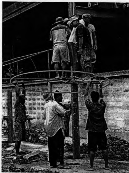
รูปที่ 3.11 ลักษณะของไม้กระดานจำนวน 2 แผ่นที่ใช้สำหรับยื่นขย่ม
