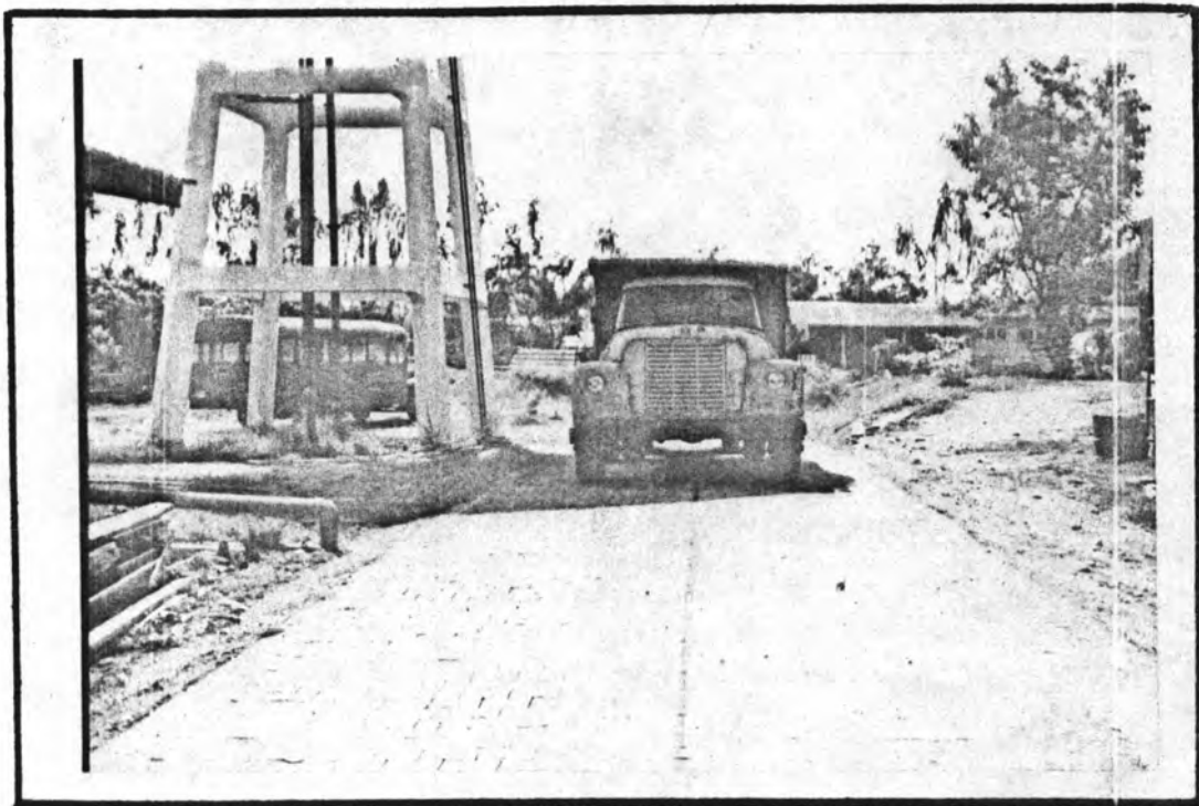
รูปที่ 4.18 เปิดให้รถวิ่งผ่านถนนทดสอบโดยกำหนดระยะร่องล้อที่แน่นอน
