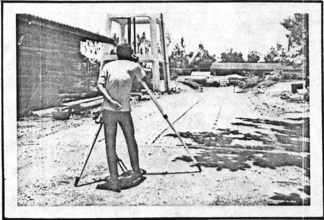
รูปที่ 4.17 เก็บค่าระดับของแผ่นคอนกรีตบล็อกก่อนเปิดให้รถวิ่งผ่าน.
