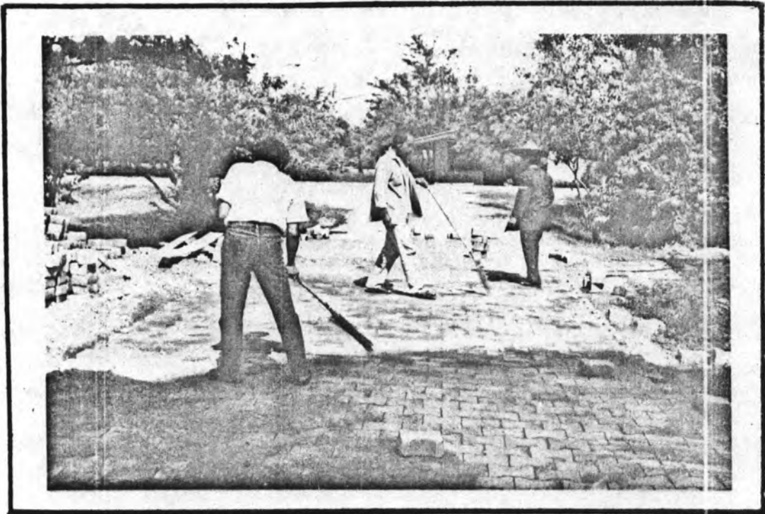
รูปที่ 4.14 กวาดทรายเพื่อแทรกรอยต่อระหว่างแผ่นคอนกรีตบล็อก
