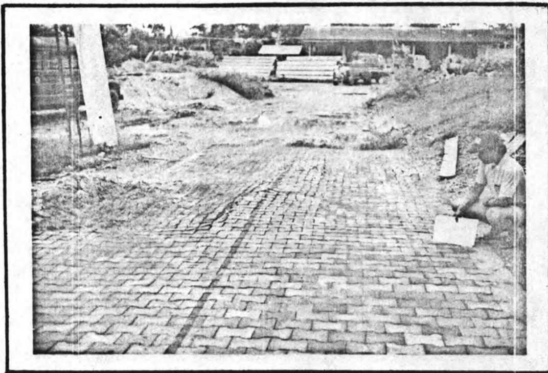
รูปที่ 4.22 การทรุดตัวของแผ่นคอนกรีตบล็อกหนา 5 ซม. เมื่อให้รถวิ่งผ่าน 700 เที่ยว
