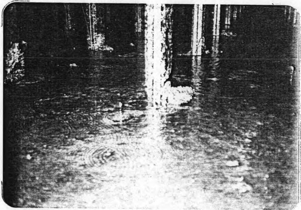
รูปที่ 7-2 เส้าคอนกรีตที่ชำรุดจากการกักเซาะและการกักกรอน
