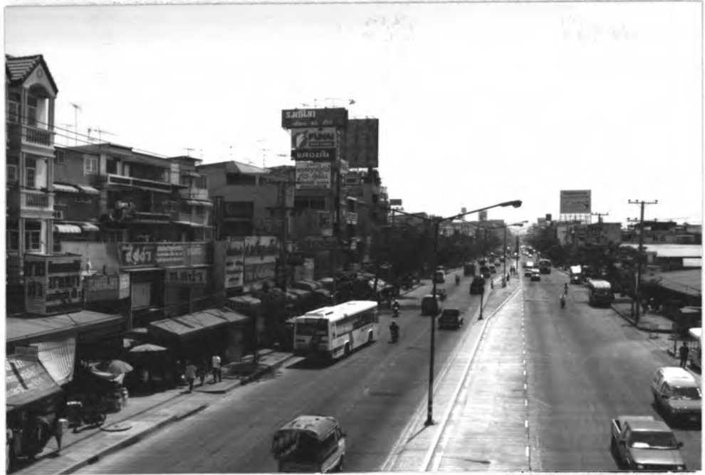
บริเวณสะพานใหม่ คอนเมือง
