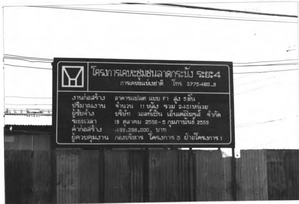
โครงการใหม่ที่กำลังก่อสร้าง
