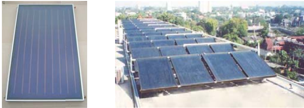
ภาพที่ 2.11 แผงรับแสงอาทิตย์แบบแผ่นเรียบ[9]
