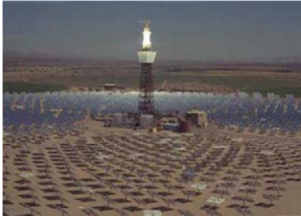
ภาพที่ 2.8 แสดงรูปแบบระบบหอคอยและหลักการทำงาน [10]
