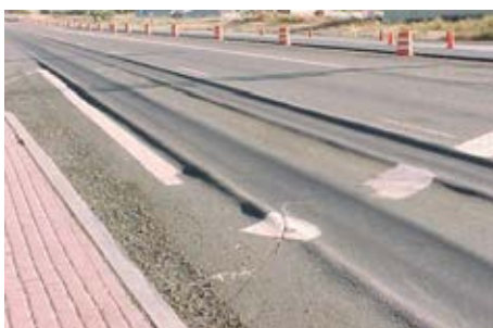
ภาพที่ 2.1 ความเสียหายแบบร่องล้อ (Pavement Interactive,2012: Online)
