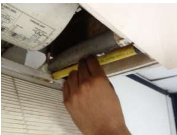
รูป 35 ตรวจสอบภาพและทำความสะอาดท่อและถาดรองน้ำทิ้ง
