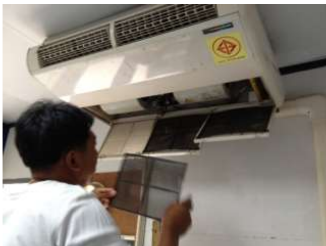
รูป 31 การทำความสะอาดแผ่นกรอง
