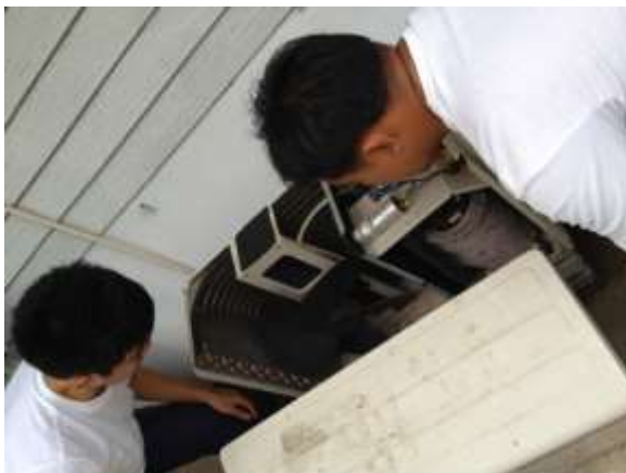
รูป 39 ตรวจสอบโครงคอยล์ร้อน
