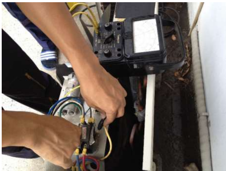
รูป 43 ตรวจสอบการทำงานของแมกเนติกคอนแทคเตอร์
