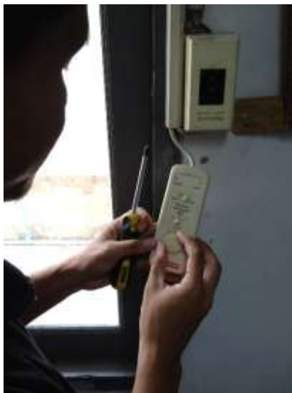
รูป 33 ตรวจสอบสวิตช์ควบคุมอุณหภูมิ
