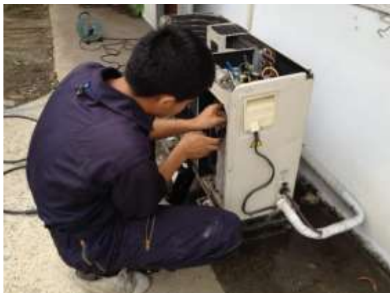
รูป 46 ตรวจสอบสภาพคอมเพรสเซอร์
