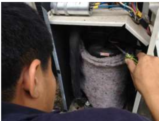
รูป 45 ตรวจสอบภาพคอมเพรสเซอร์
