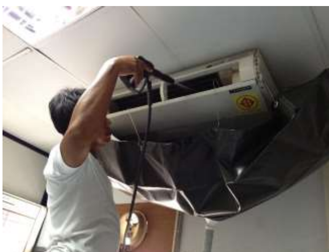
รูป 32 การทำความสะอาด แผงคอยล์เย็น
