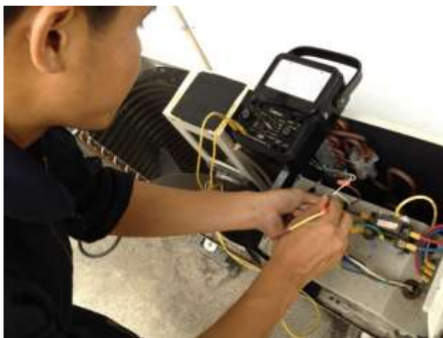
รูป 40 ตรวจสอบมอเตอร์คอยล์ร้อน
