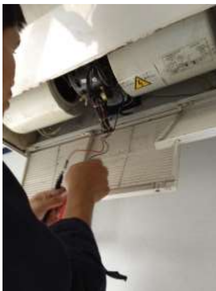
รูป 38 ตรวจสอบสภาพมอเตอร์ และใบพัดลมคอยล์เย็น
