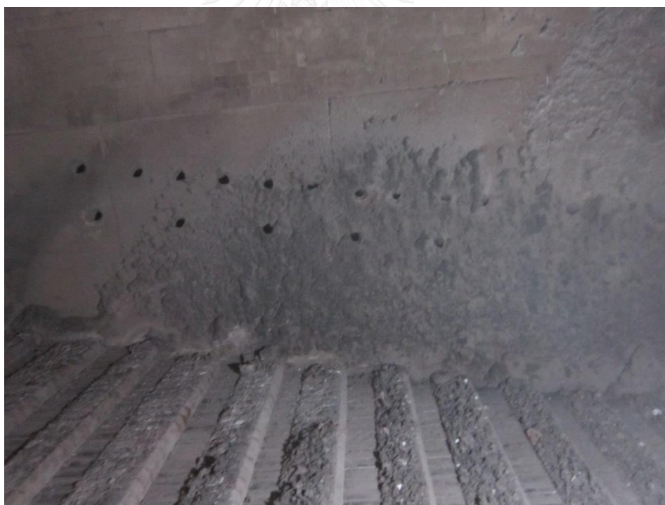
รูปที่ 17 สแลก (Slag) ที่เกิดขึ้นตามผนังของห้องเผาไหม้และตะกรับทำให้เกิดลมที่นำเข้ามาใช้ในห้องเผาไหม้ไม่สามารถไหลผ่านได้
