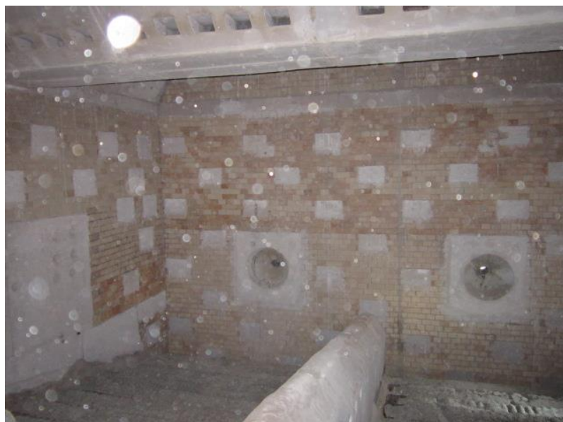
รูปที่ 25 ภายในห้องเผาไหม้ชนิดสโตเกอร์ (Stoker)
