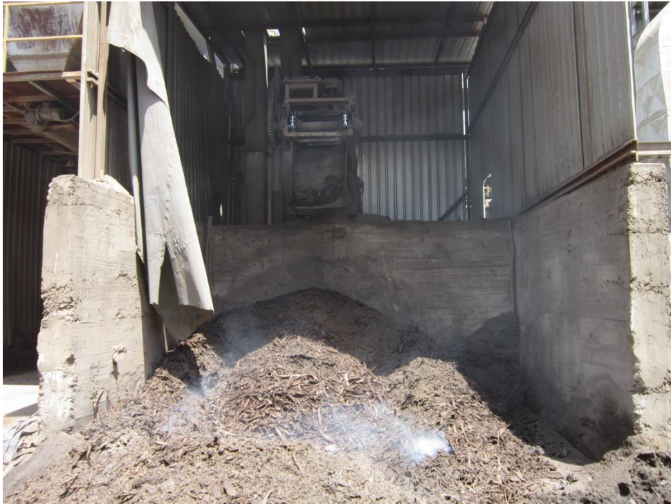
รูปที่ 20 เศษเปลือกไม้ยูคาลิปตัสที่เหลือจากการเผาไหม้เนื่องจากมีค่าความชื้นสูงถูกลำเลียงออกมาจากห้องเผาไหม้
