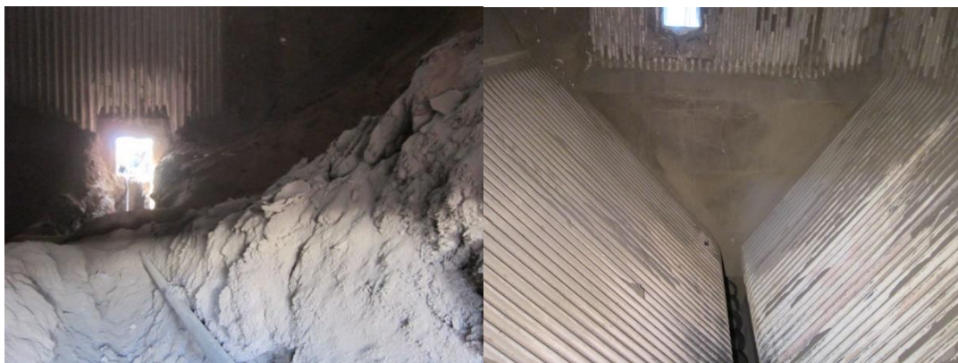
รูปที่ 19 แสดงให้เห็นถึงภายในห้องของหม้อต้มไอน้ำที่มีการอุดตันของขี้เถ้าลอย (Fly Ash) เนื่องจากการใช้เชื้อเพลิงที่มีอัตราส่วนการผสมของเปลือกไม้ยูคาลิปต์สมากเกินไป
