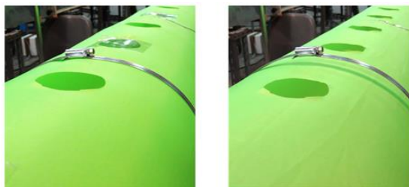
รูปที่ 4-19 ลักษณะของท่อลมผ้าที่คงรูปเหมาะสม(ซ้าย) และไม่เหมาะสม(ขวา)
